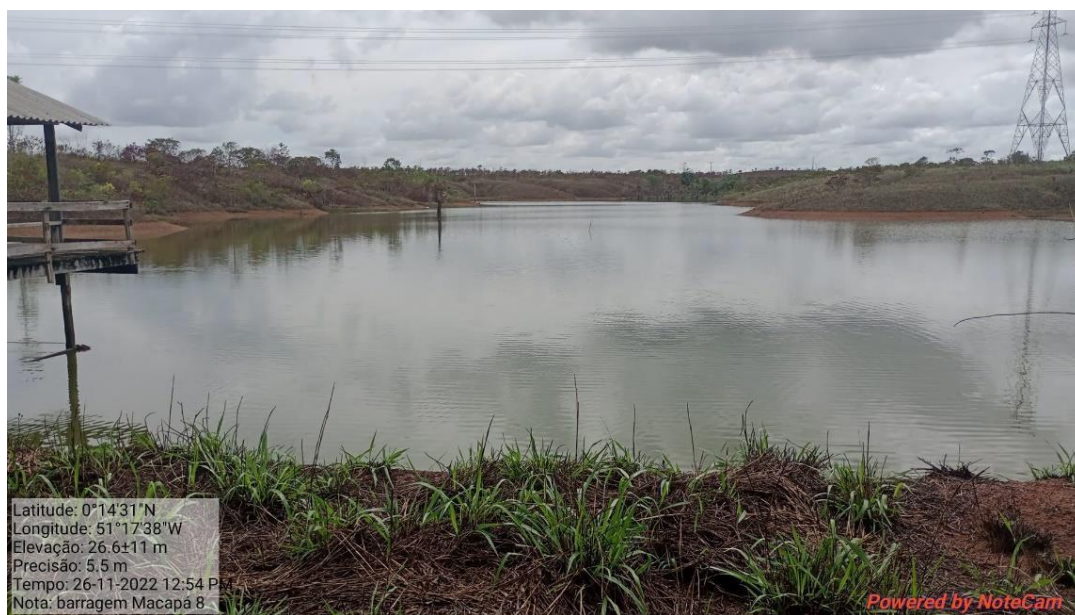
Fotografia 90: Reservatório da barragem.
