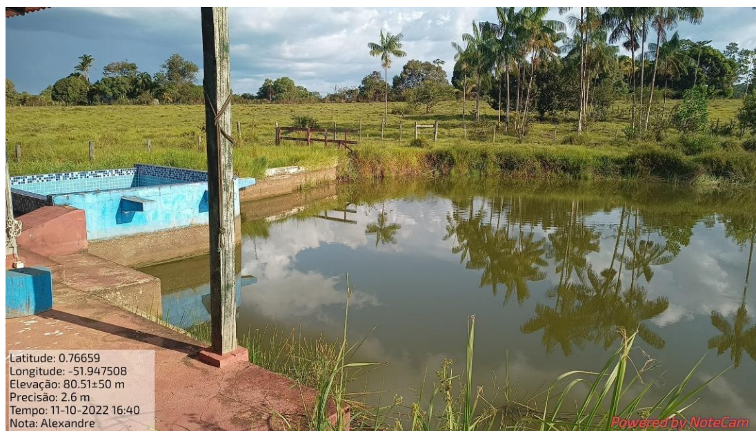
Fotografia 7: Talude de montante de concreto.
