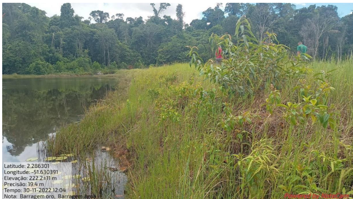
Fotografia 20: Presença de vegetação rasteira e arbustos no talude à montante.
