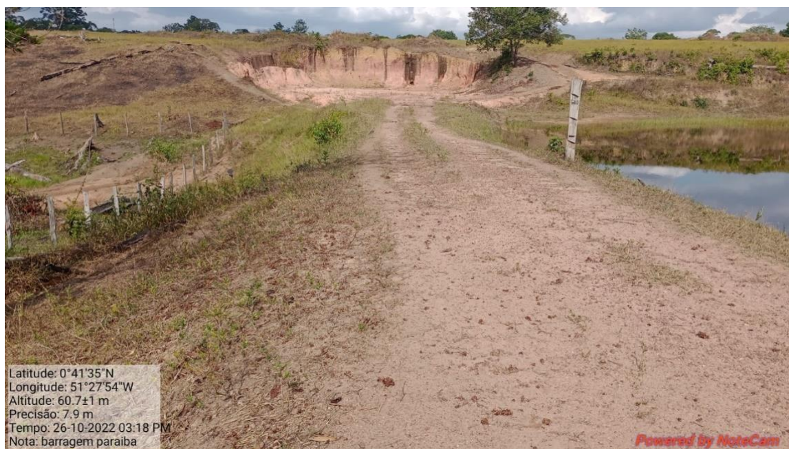
Fotografia 63: Crista da barragem Paraíba.
