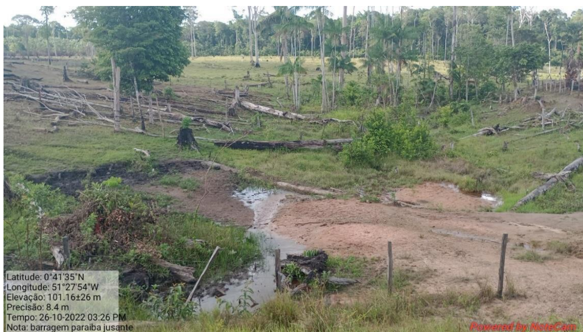
Fotografia 60: Região a jusante da barragem Paraíba.
