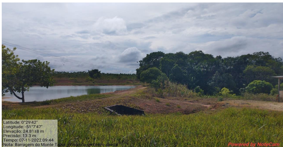
Fotografia 68 - Presença de vegetação na crista da barragem.
