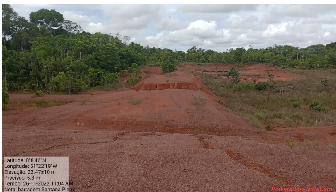
Fotografia 85: Vista do Barramento.
