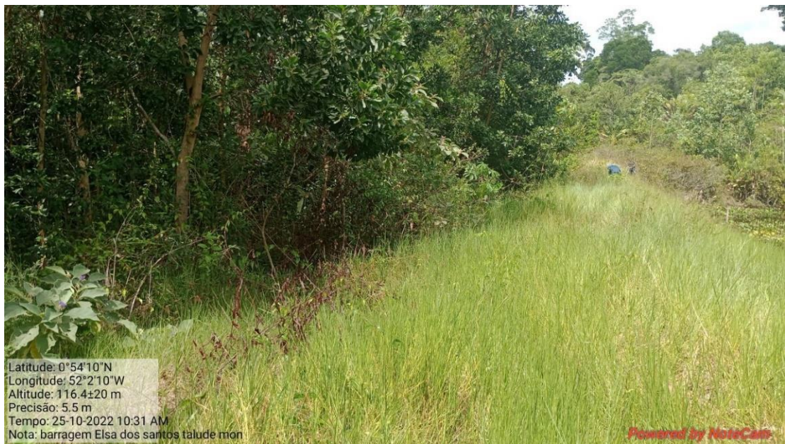
Fotografia 37: Talude de jusante da barragem.
