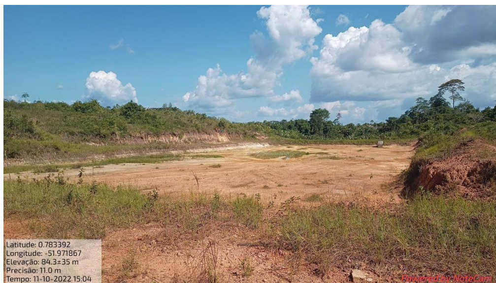
Fotografia 9: Vista geral do reservatório seco.
