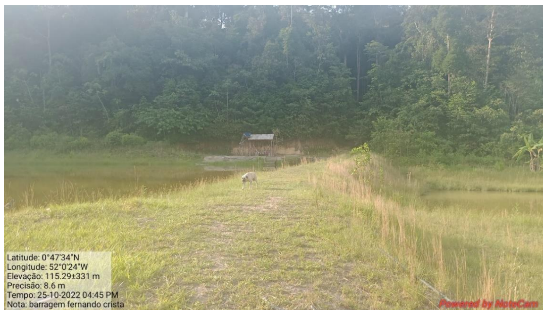
Fotografia 45: Crista da barragem Desconhecida 3- Fernando Duarte.
