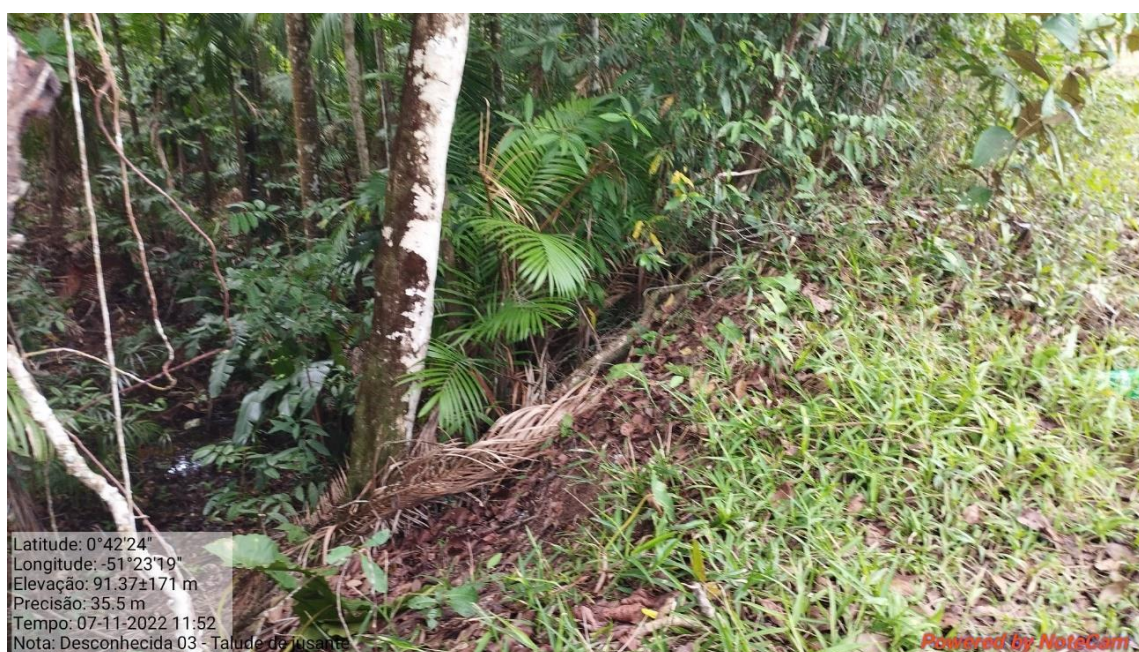
Fotografia 71 - Talude jusante da barragem desconhecida 3 com vegetação.
