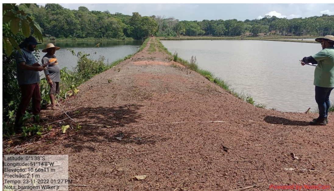
Fotografia 83: Crista da Barragem Principal.
