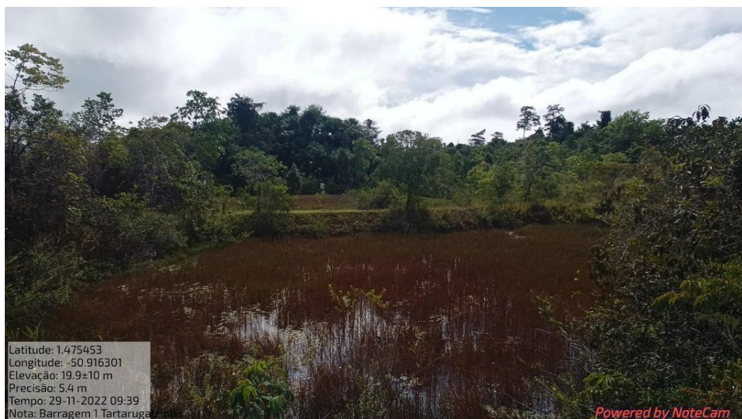
Fotografia 27: Tanques de piscicultura à jusante da barragem.
