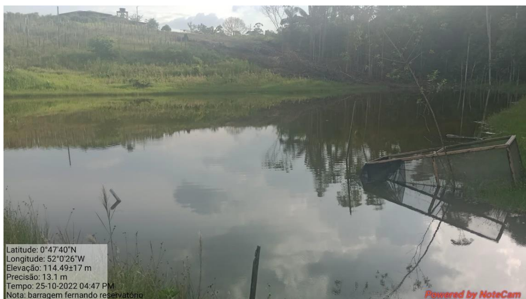
Fotografia 47: Reservatório da barragem Desconhecida 3- Fernando Duarte.
