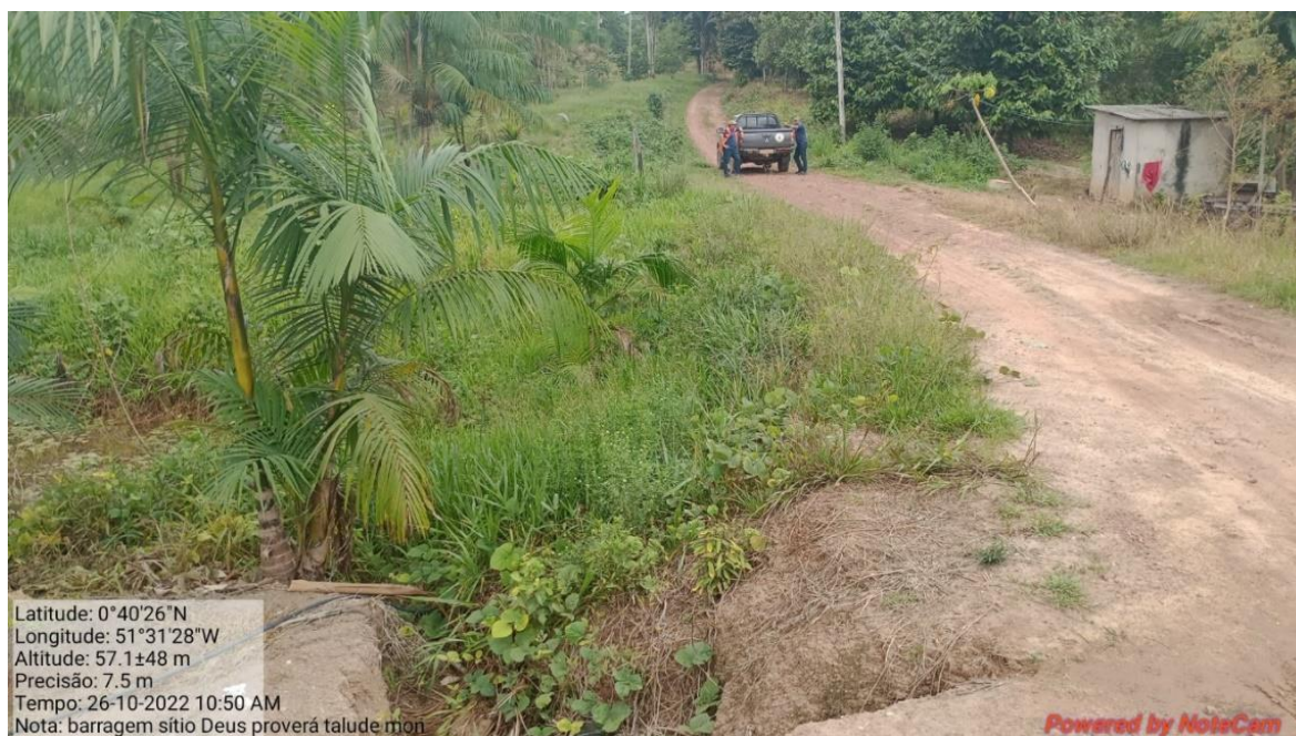
Fotografia 49: Talude de montante da barragem Deus Proverá.
