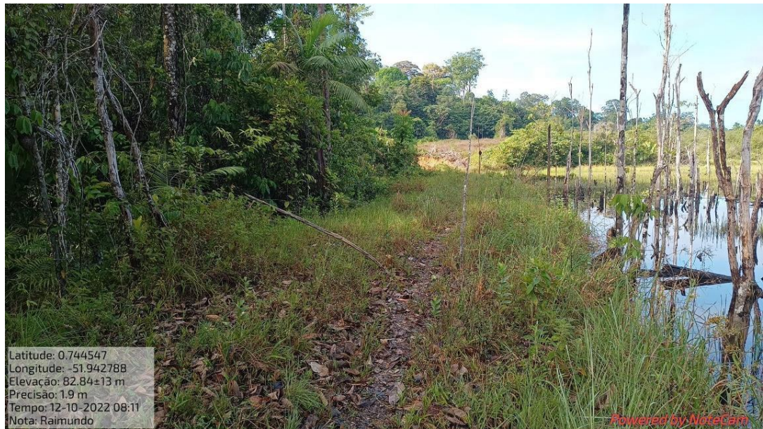
Fotografia 32: Vegetação presente na crista e nos taludes.
