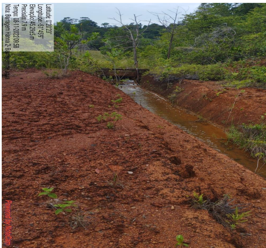
Fotografia 79: Extravasor em madeira apresentado vegetação.
