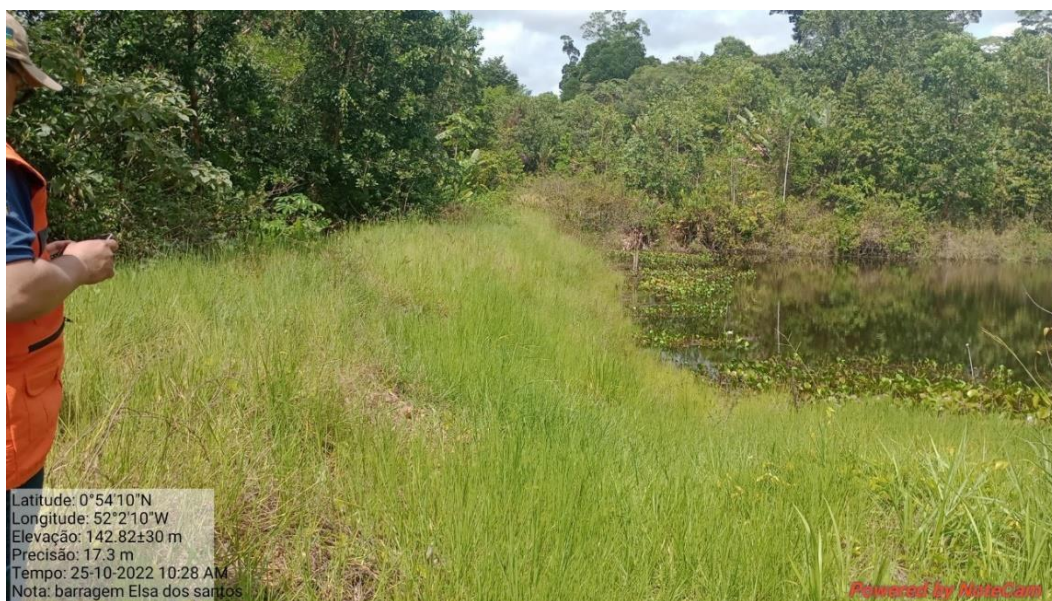
Fotografia 35: Crista da barragem.
