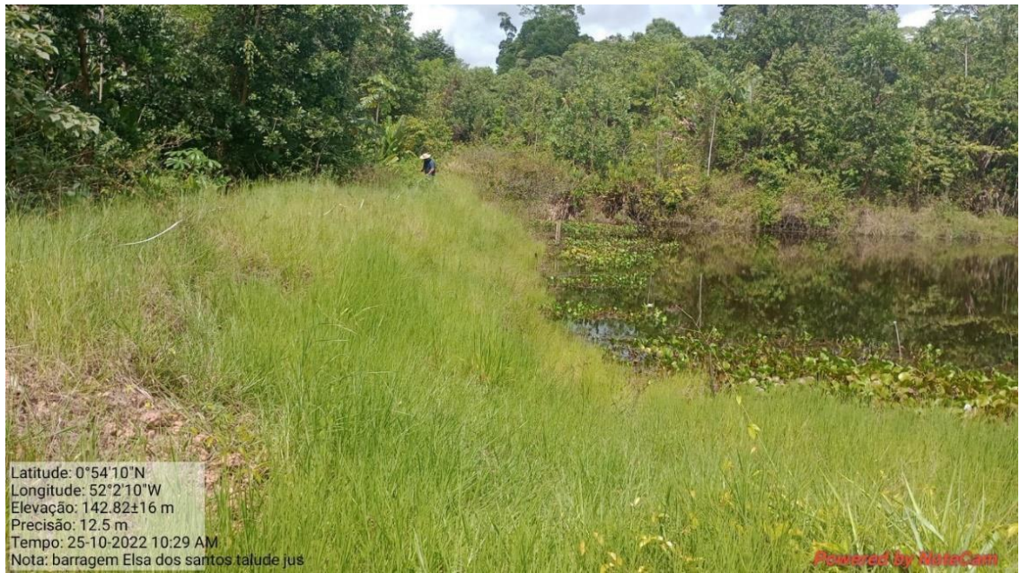
Fotografia 36: Talude de montante.
