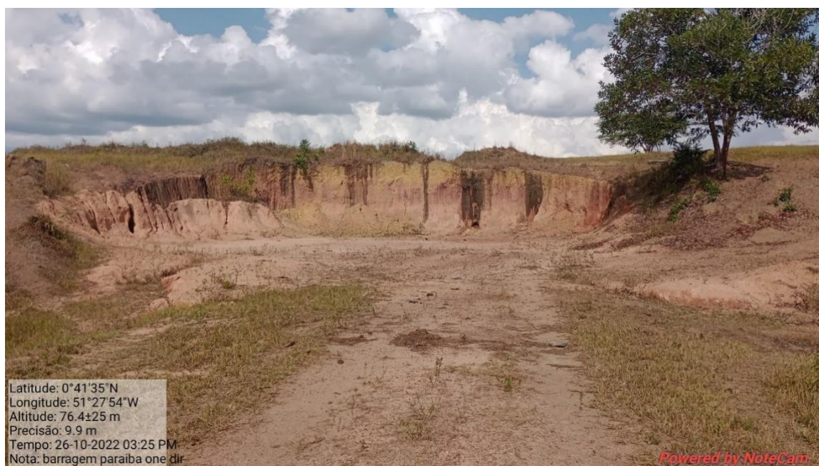
Fotografia 64: Ombreira direita da barragem Paraíba.
