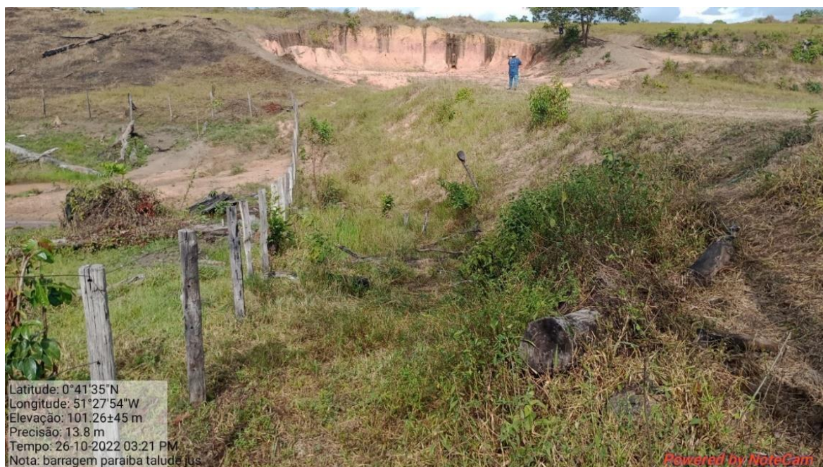
Fotografia 59: Talude de jusante da barragem Paraíba.
