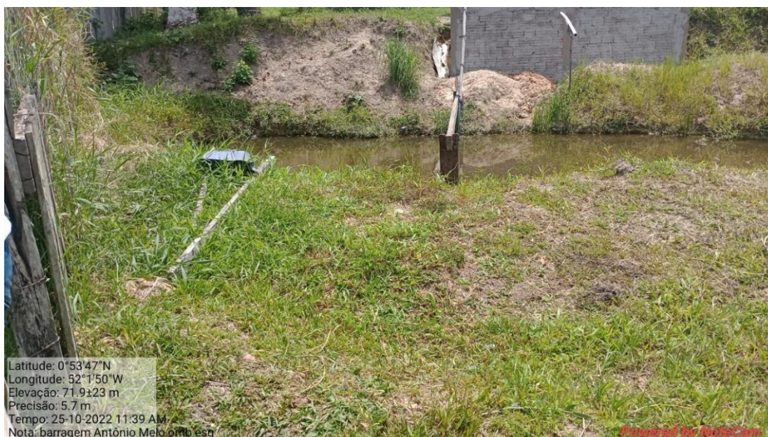
Fotografia 41: Ombreira esquerda barragem 1 Antônio Melo.
