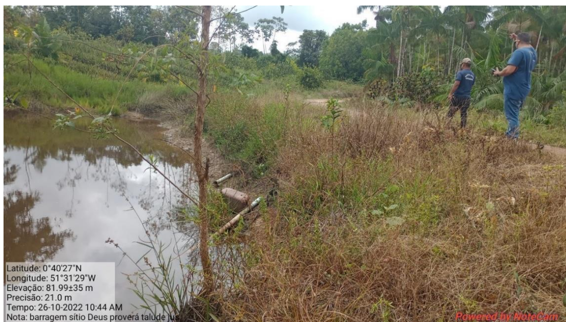
Fotografia 48: Talude de jusante da barragem Deus Proverá.
