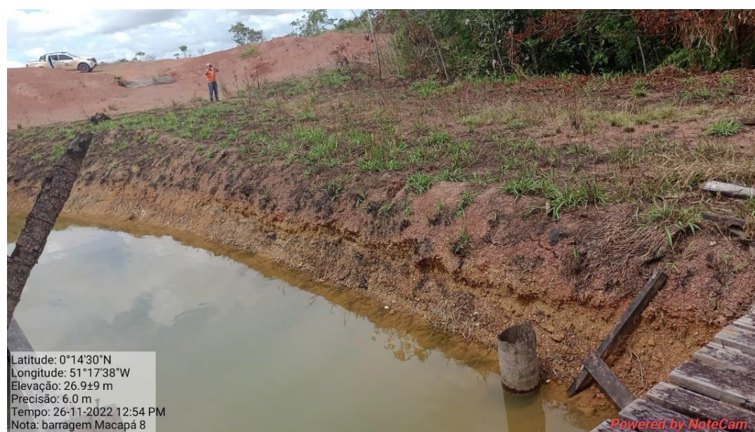
Fotografia 91: Crista do Barramento.
