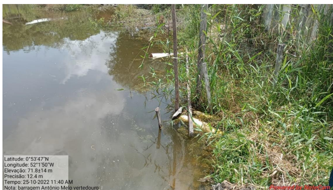
Fotografia 42:-Vertedouro da barragem Antônio Melo.
