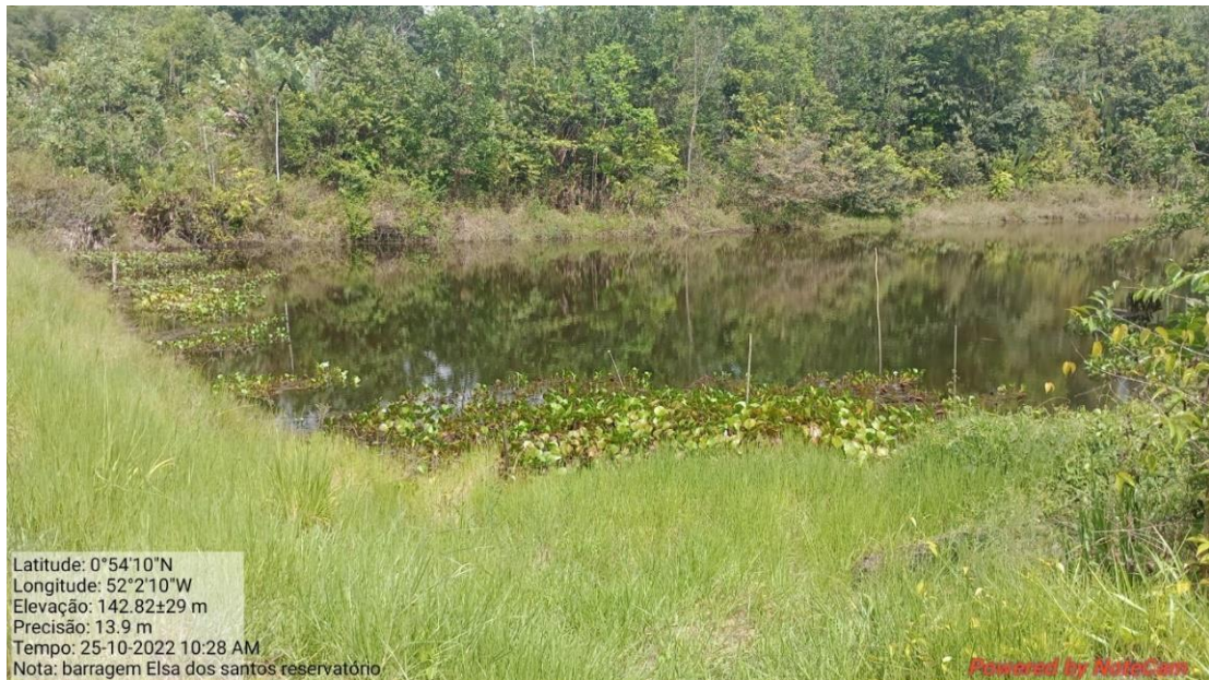
Fotografia 38: Reservatório da barragem.
