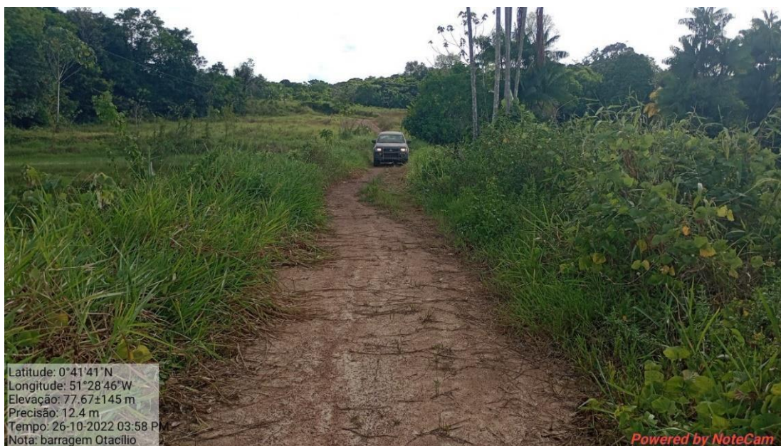
Fotografia 56: Crista da barragem Nova Esperança.
