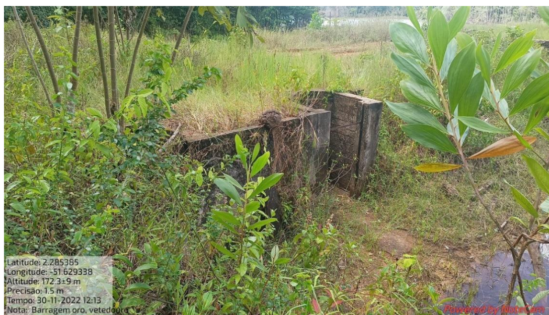
Fotografia 23: Vegetação no vertedouro.
