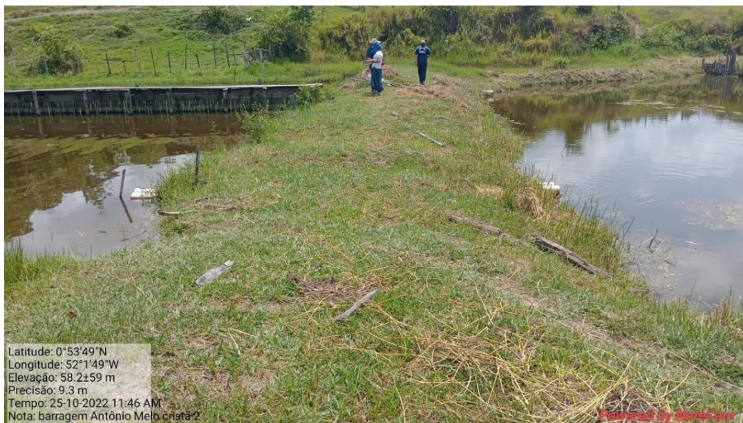
Fotografia 39: Crista barragem 2 Antônio Melo.
