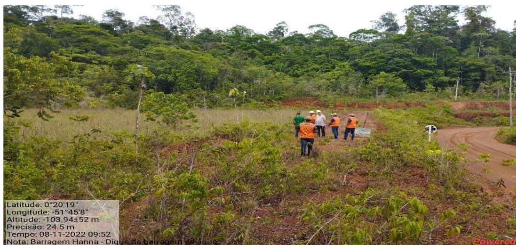
Fotografia 77: Talude jusante e crista com vegetação.
