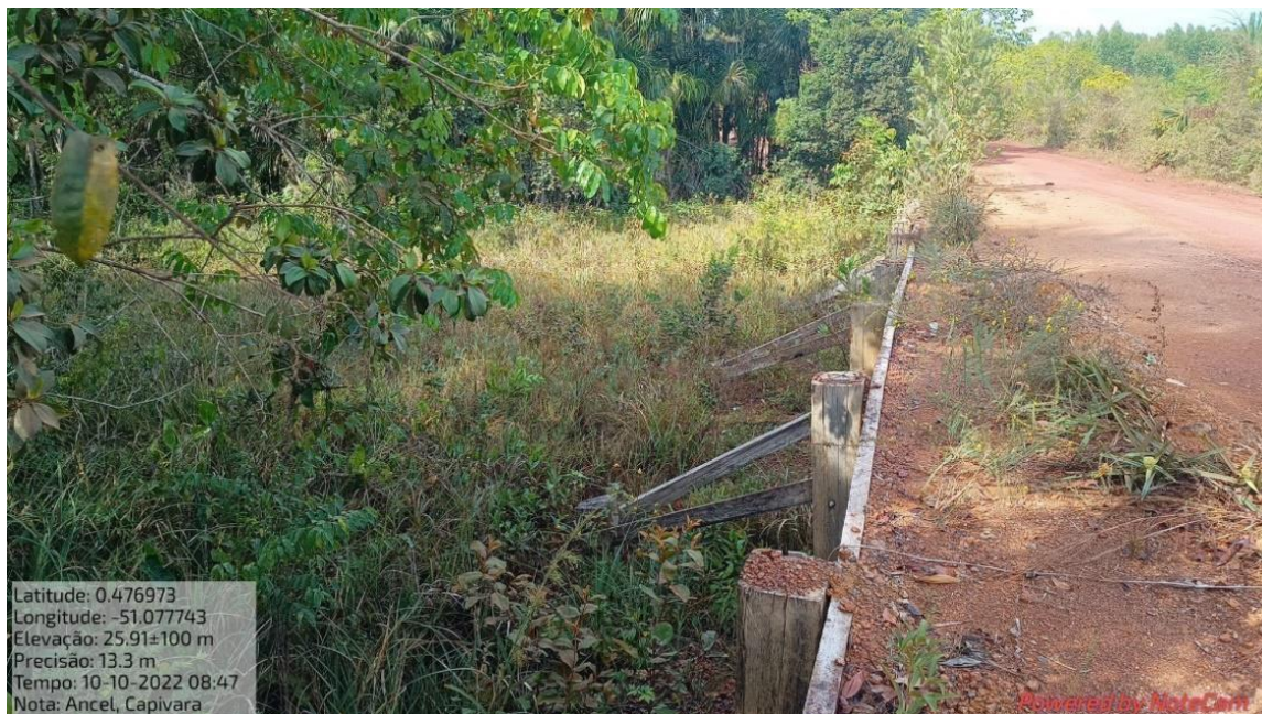
Fotografia 1: Uso de madeira para conter erosão no talude de jusante.
