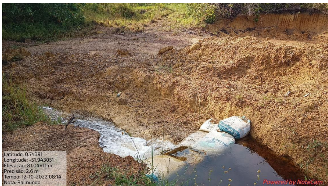
Fotografia 33: Retirada de material nas proximidades da ombreira direita.
