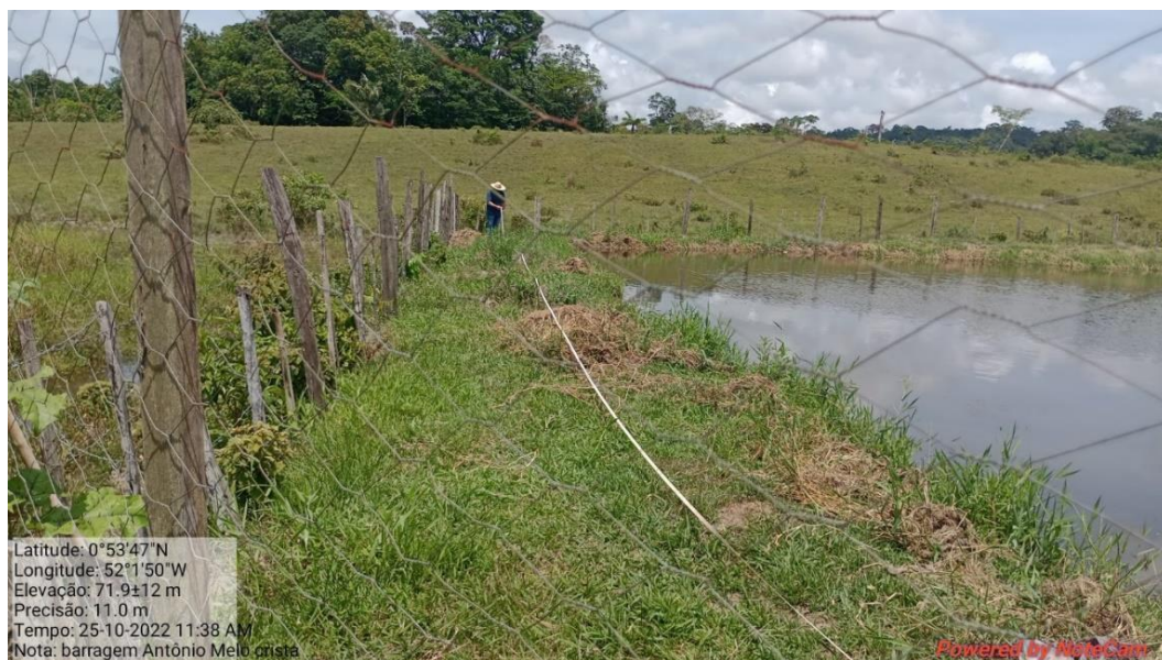
Fotografia 40: Crista da barragem Antônio Melo
