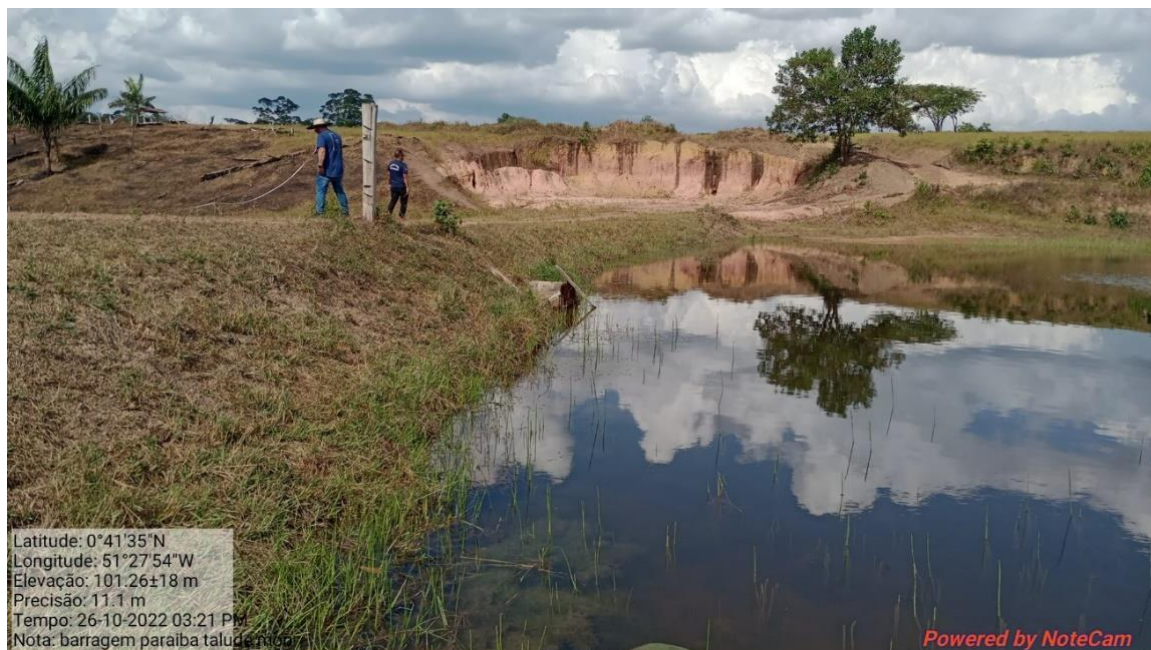
Fotografia 58: Talude de montante da barragem Paraíba.
