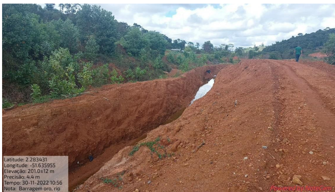
Fotografia 25: Canal construído pela empresa Oro Amapá Mineração para escoar o excesso de água da Barragem Oro.
