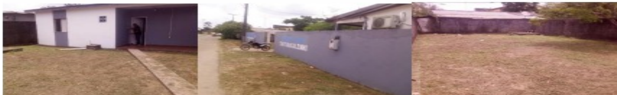
Figura 34- Roçagem do Prédio de Circunscrição de Trânsito (CINETRAN).
