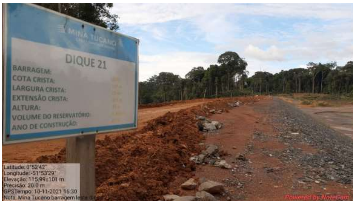
Fotografia 38 - Vista do Dique 21.
