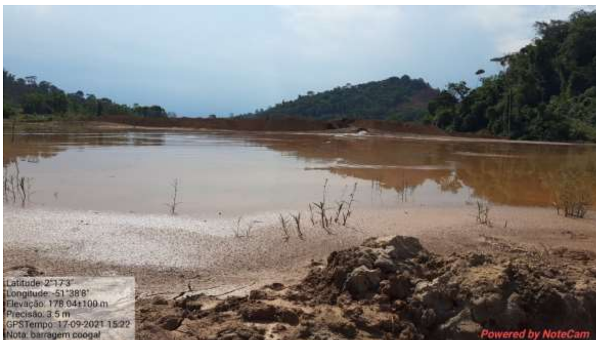
Fotografia 6 - Mesma cava na área da Coogal, preenchida por rejeitos em setembro de 2021.
