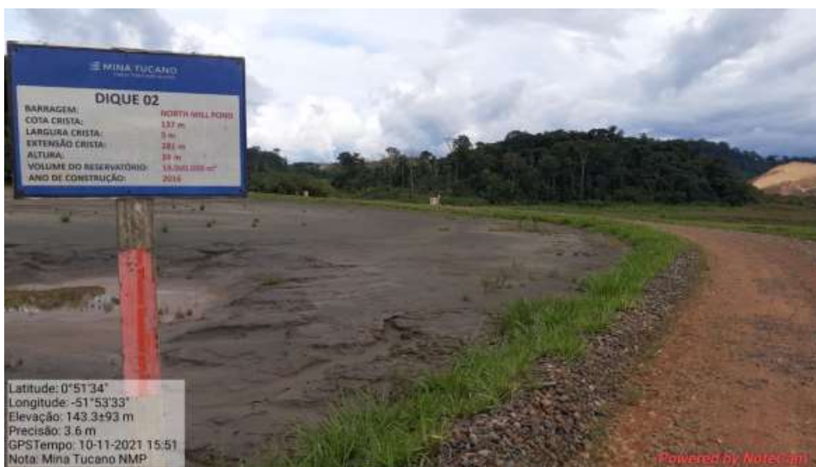
Fotografia 32 - Vista do Dique 02.
