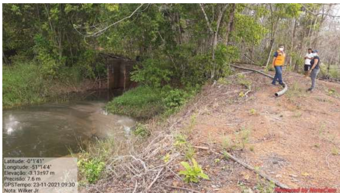
Fotografia 122 - Sangradouro na margem esquerda do barramento.
