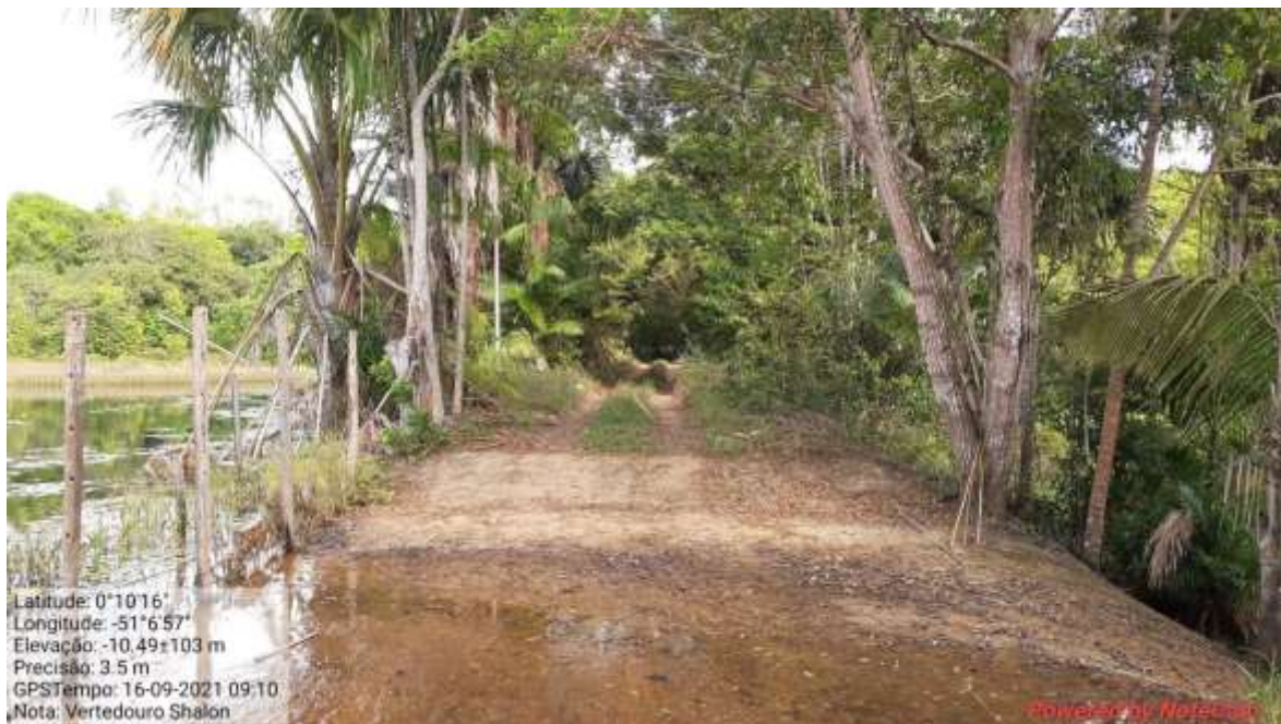
Fotografia 63 - Crista da barragem.
