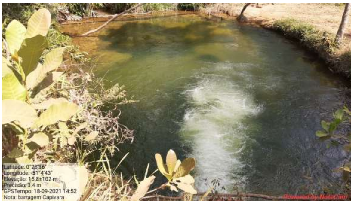
Fotografia 85 - Extravasor na M/D da barragem.
