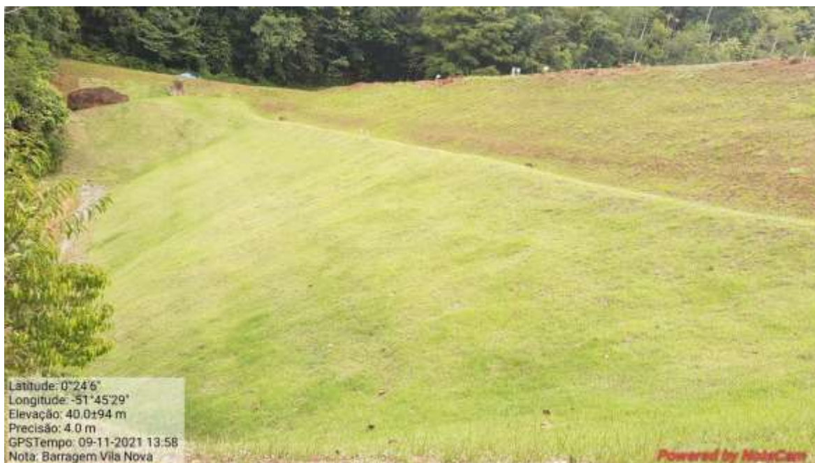
Fotografia 15 - Vista do talude de jusante da barragem Vila Nova.
