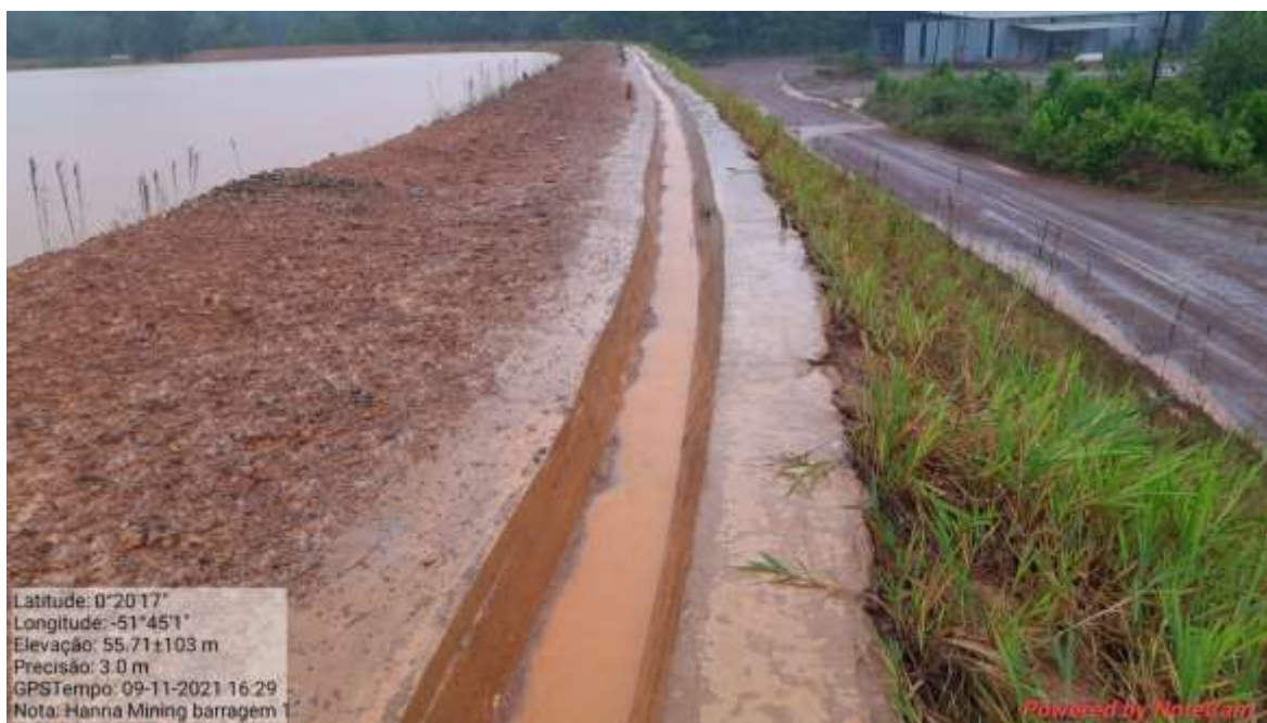
Fotografia 19 - Canaleta construída na crista da barragem.
