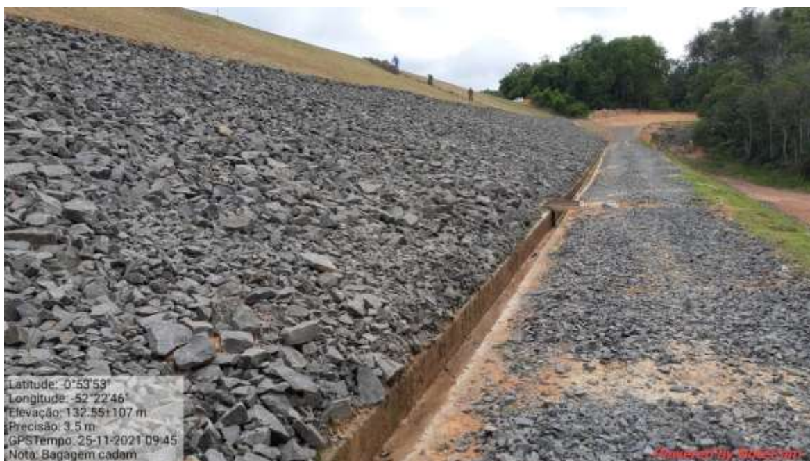
Fotografia 49 - Talude de montante protegido com enrocamento.
