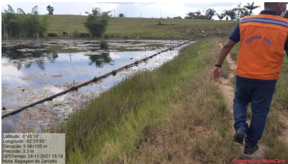
Fotografia 126 - Talude de montante.
