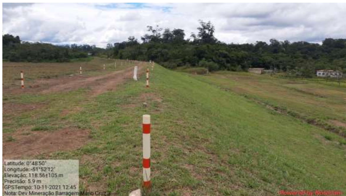
Fotografia 27 – Crista e talude de jusante do Dique 3.
