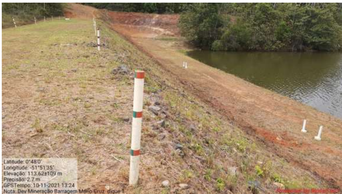
Fotografia 30 - Crista e talude de jusante do Dique 1.
