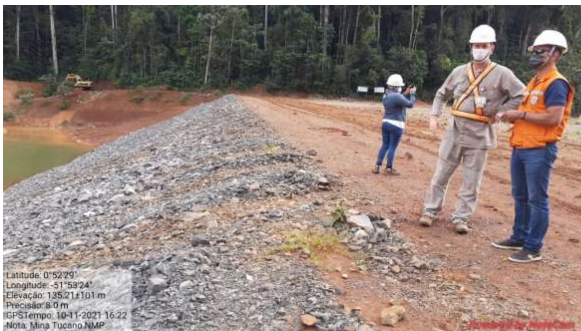
Fotografia 36 - Vista do Dique 13.
