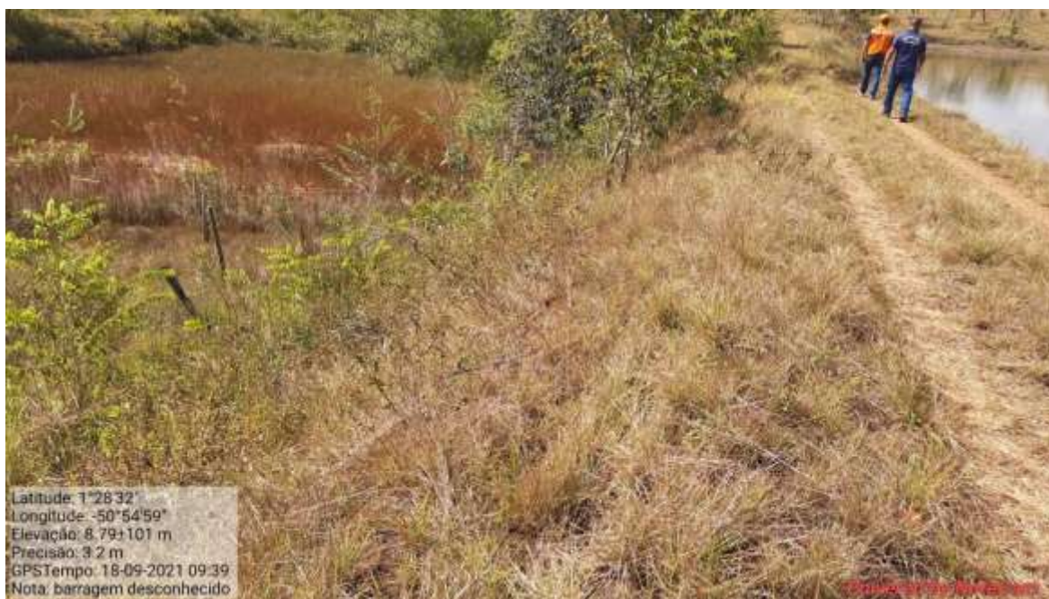
Fotografia 135 - Talude de jusante.
