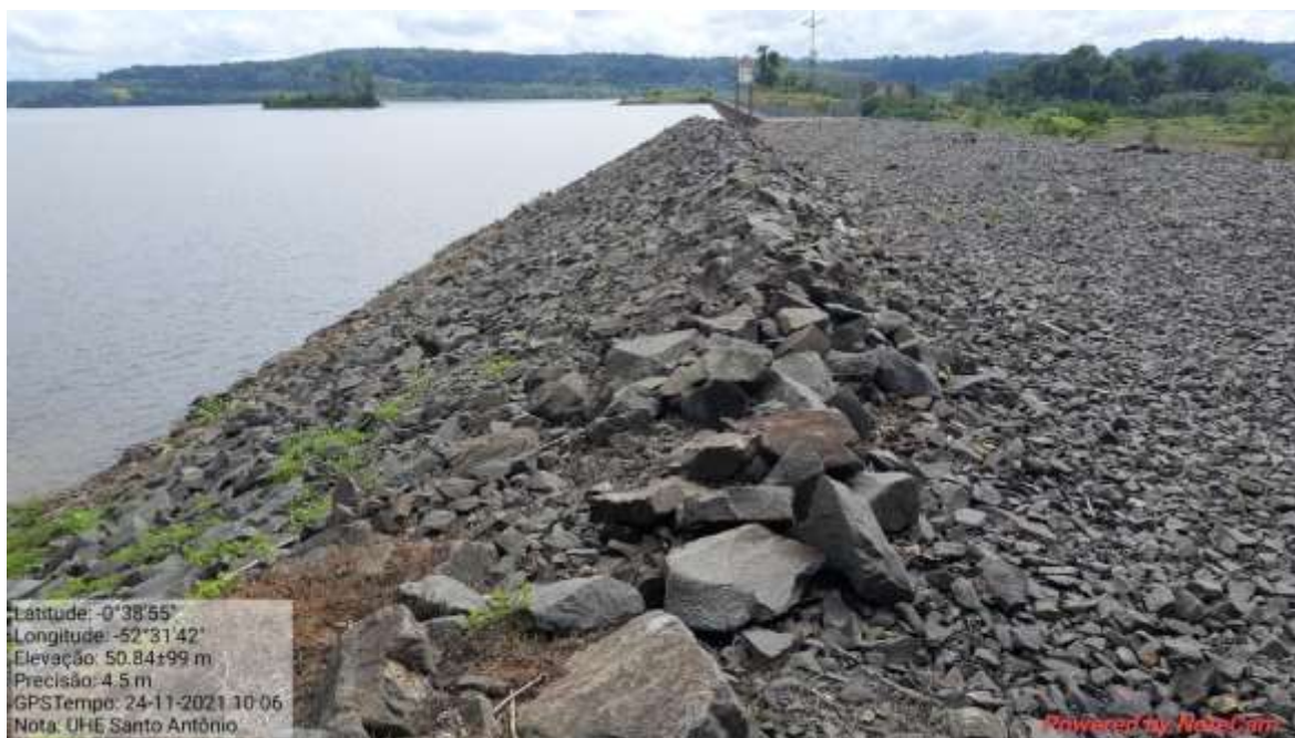
Fotografia 57 - Talude de montante.
