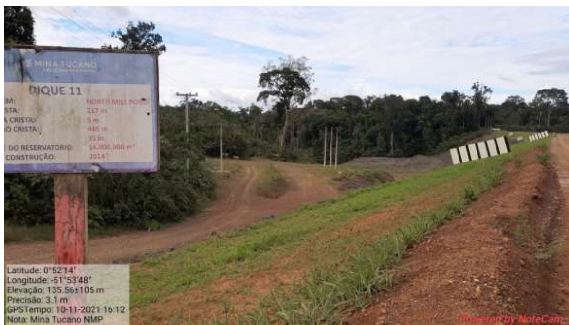
Fotografia 34 - Vista do Dique 11.
