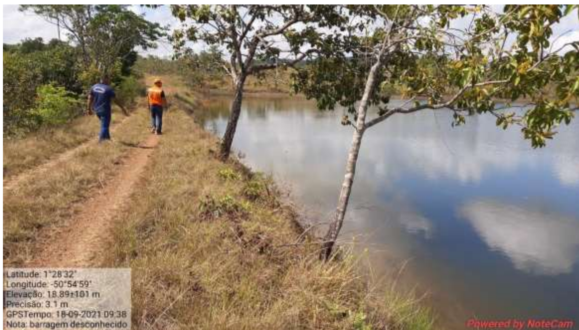
Fotografia 134 - Talude de montante com vegetação e árvores.
