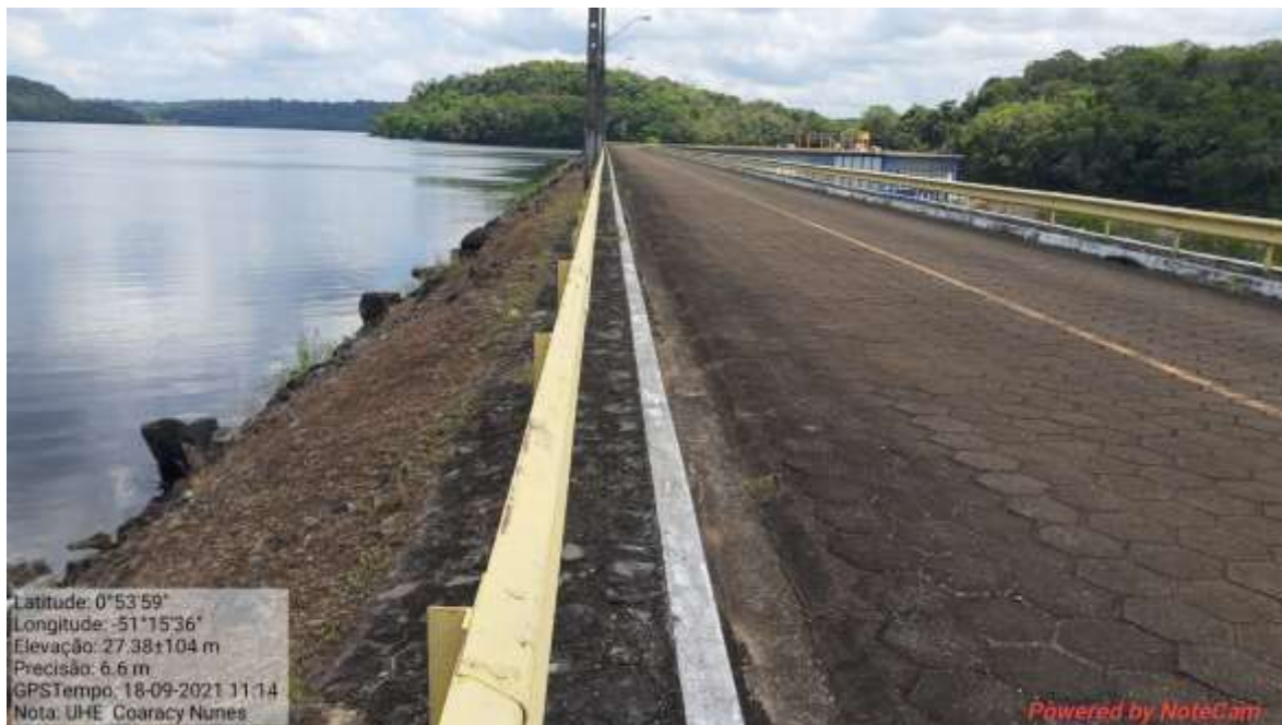
Fotografia 52 - Talude de montante.
