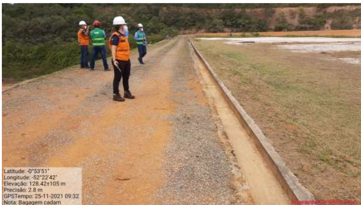
Fotografia 47 - Vista da crista da barragem da Cava.
