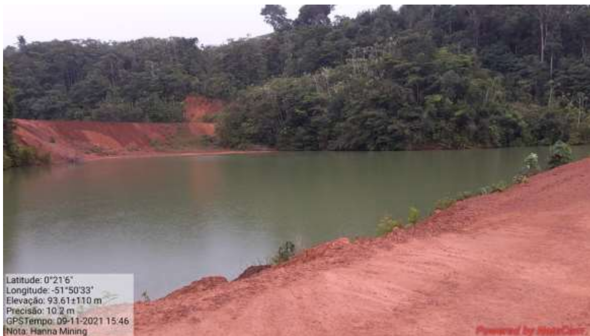
Fotografia 18 - Barragem construída a montante da barragem Samacá.
