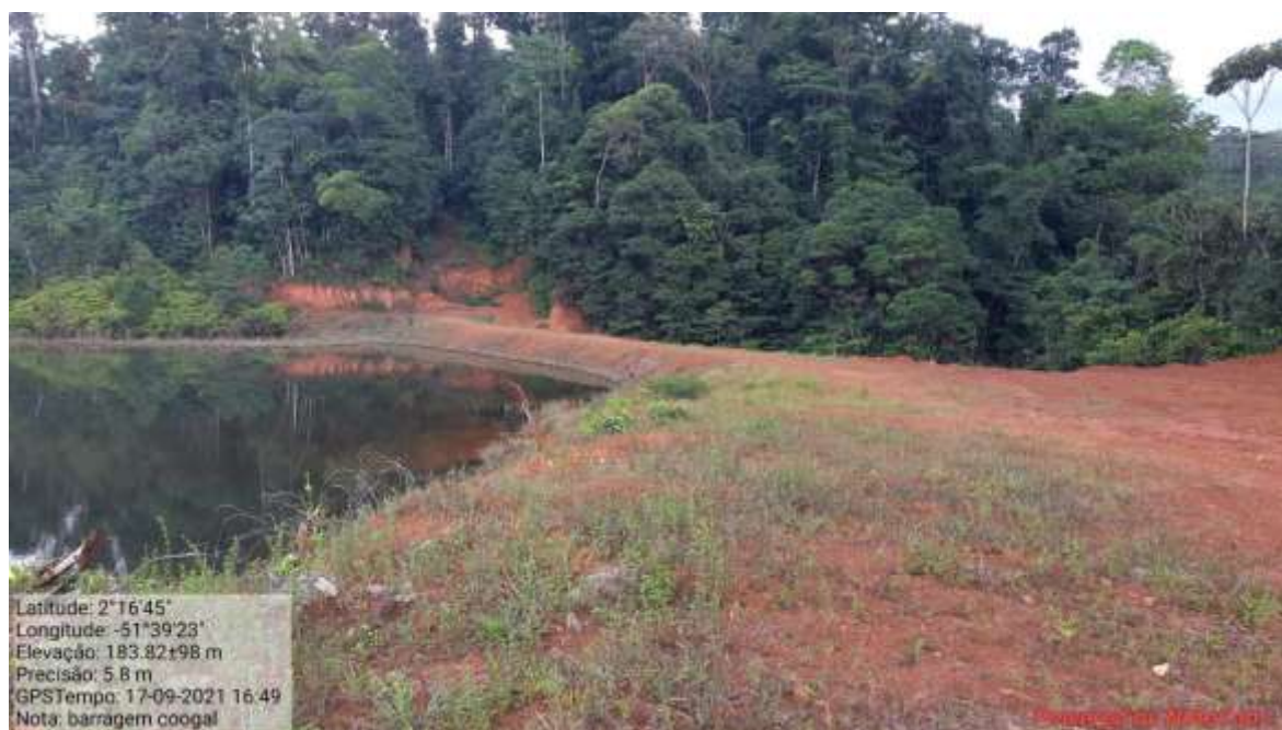
Fotografia 7 - Vista da barragem Labourie.
