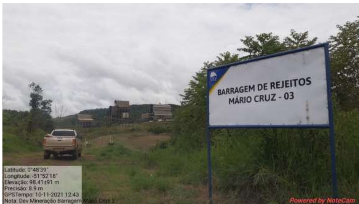
Fotografia 26 - Dique 3 com identificação.
