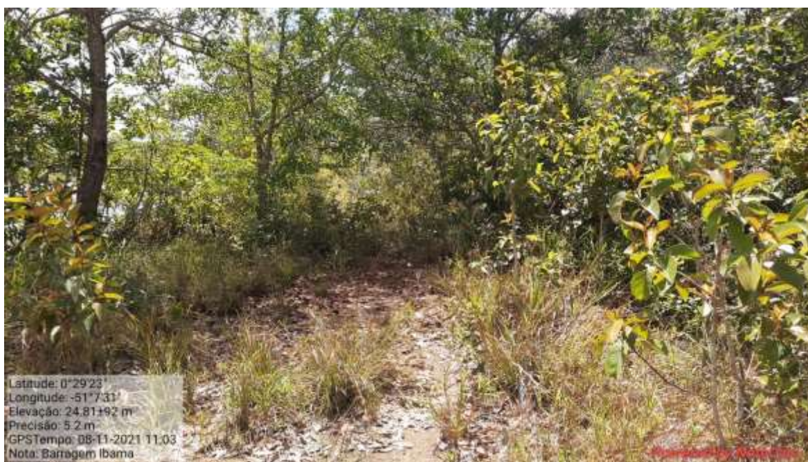
Fotografia 93- Presença de vegetação de grande porte na crista da barragem.
