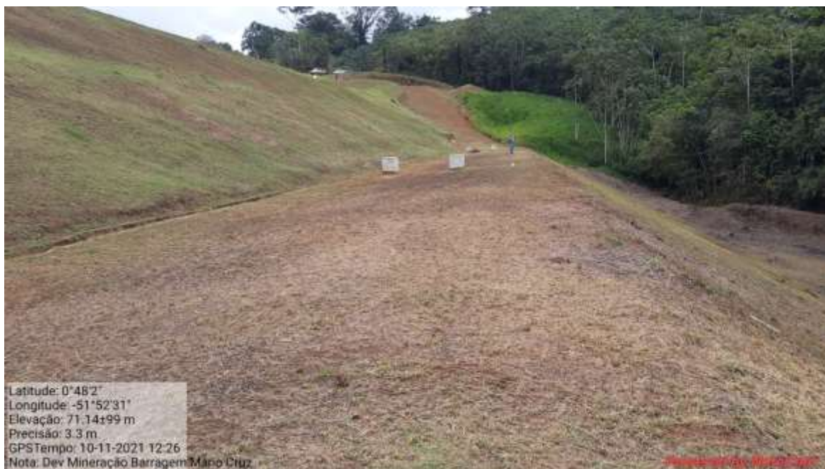
Fotografia 22 - Instrumentações sendo recuperadas na barragem Mário Cruz 1.
