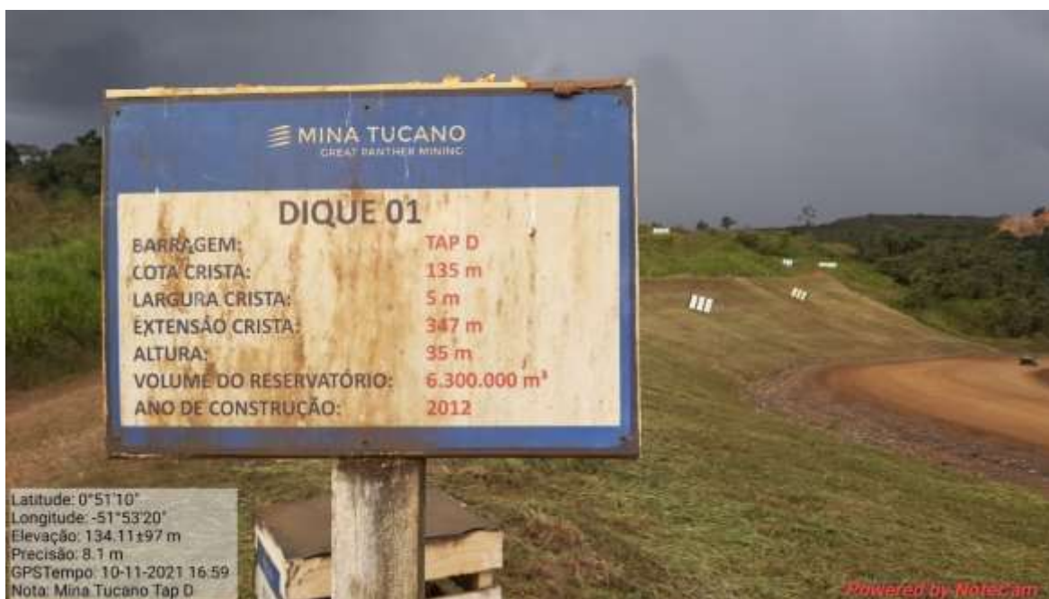
Fotografia 31 - Vista do Dique 01 (TAP D).
