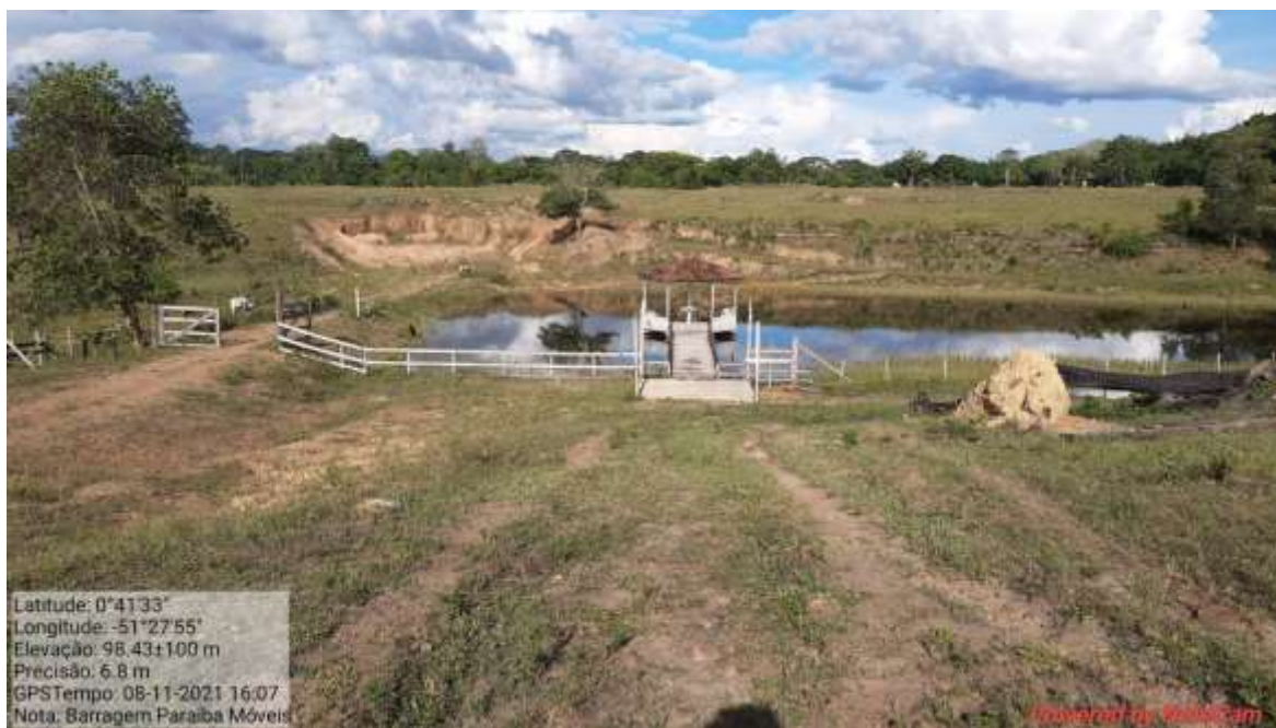
Fotografia 99 - Vista geral da barragem Paraíba.
