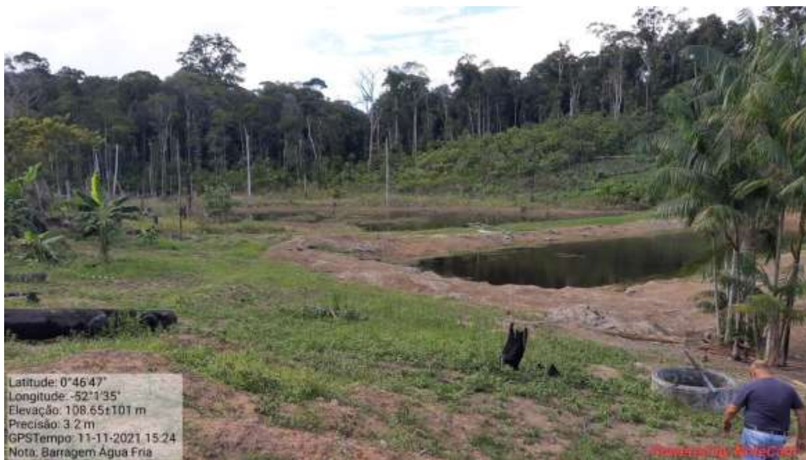
Fotografia 115 - Visão geral dos barramentos.
