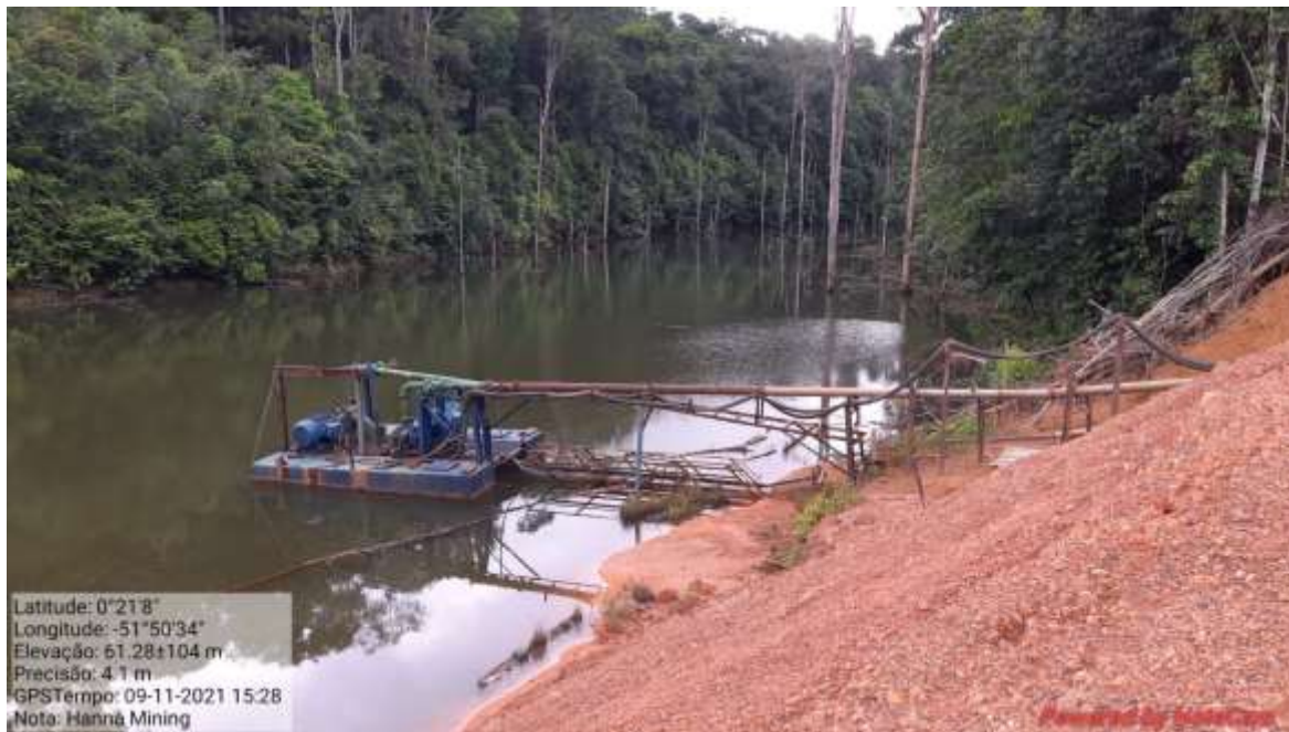
Fotografia 103 - Ponto de captação no lago da barragem.
