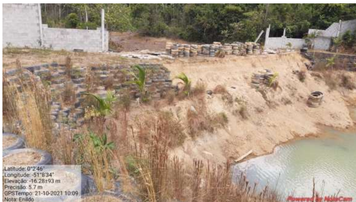
Fotografia 132 - Talude de jusante da barragem.
