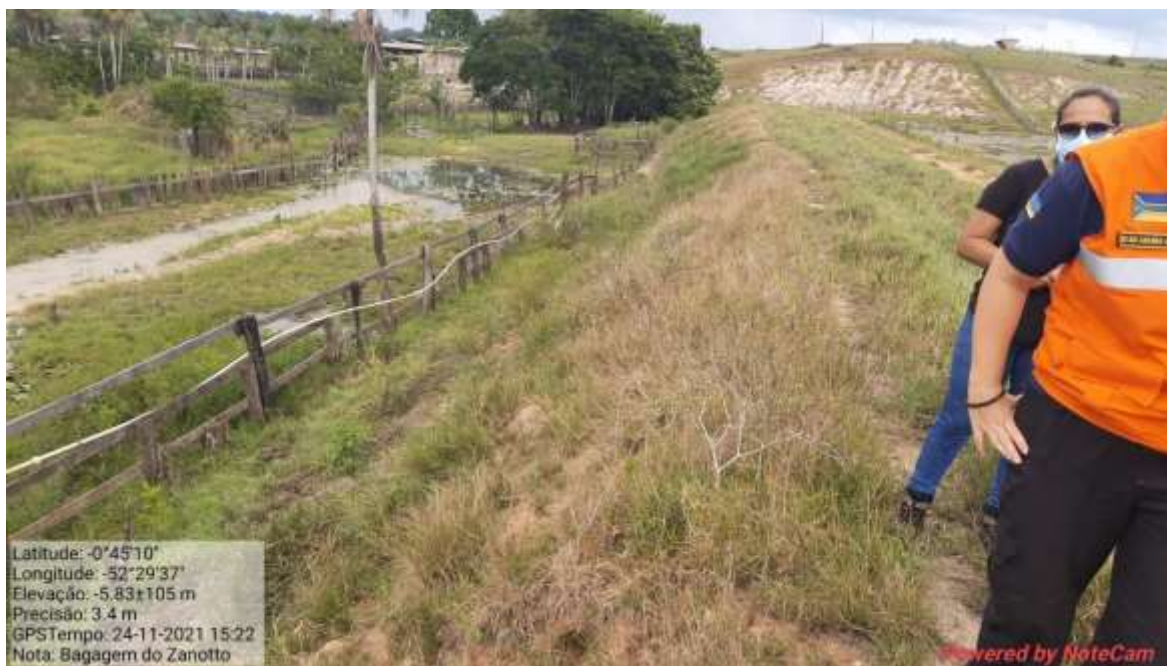
Fotografia 128 - Talude de jusante.
