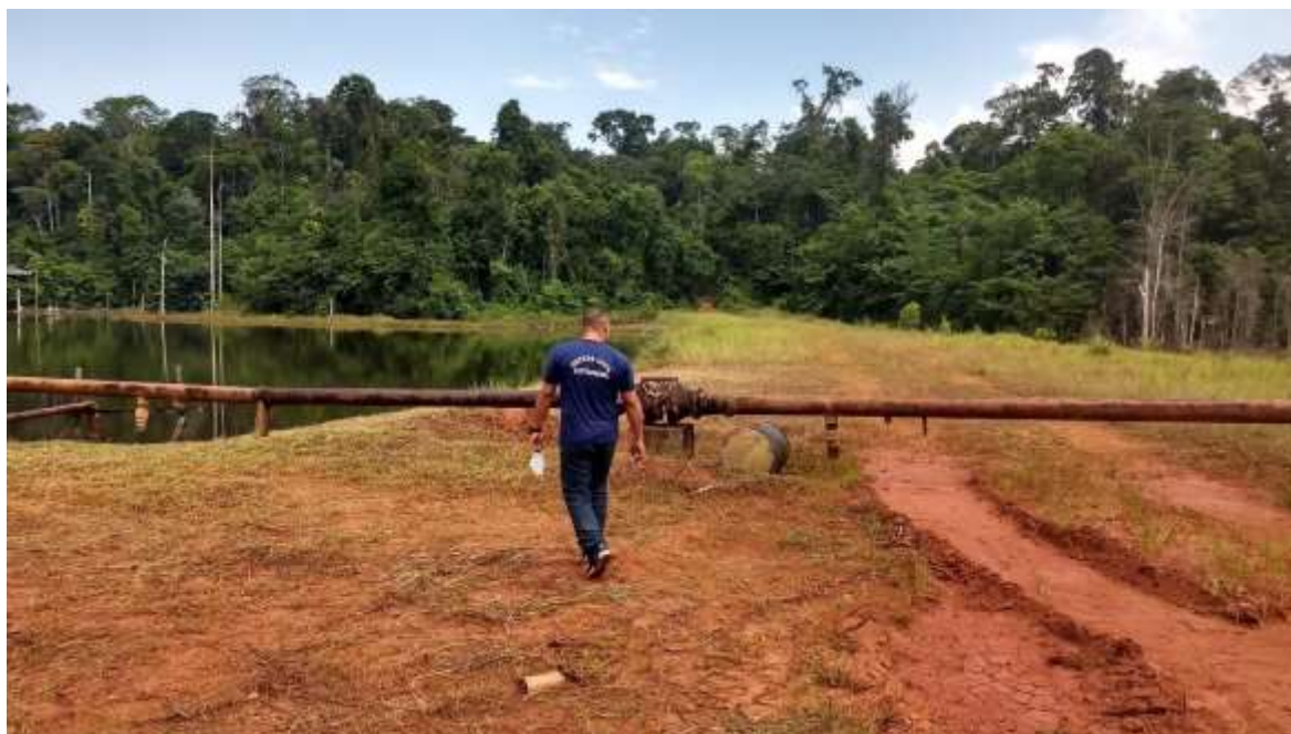
Fotografia 74 - Roçagem iniciada na crista da barragem.
