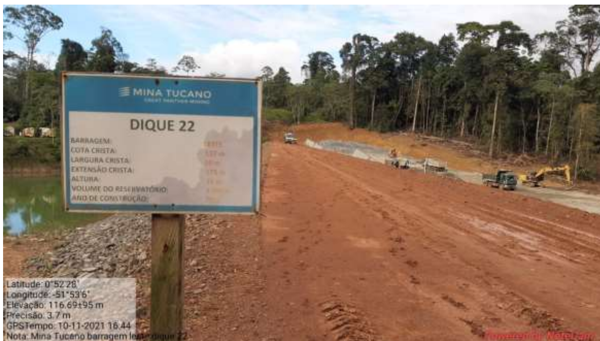
Fotografia 39 - Vista do Dique 22.
