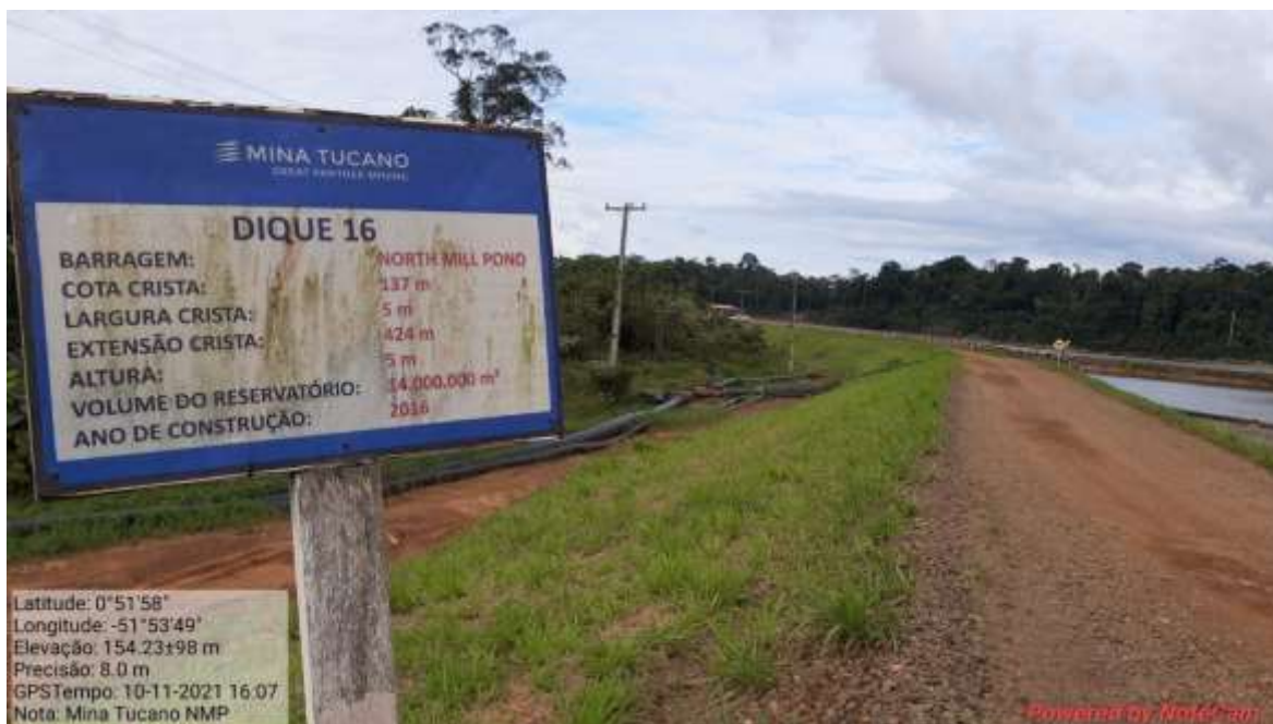
Fotografia 37 - Vista do Dique 16.
