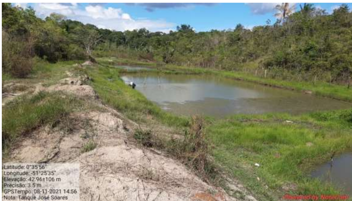
Fotografia 80 - Tanques a jusante da barragem.
