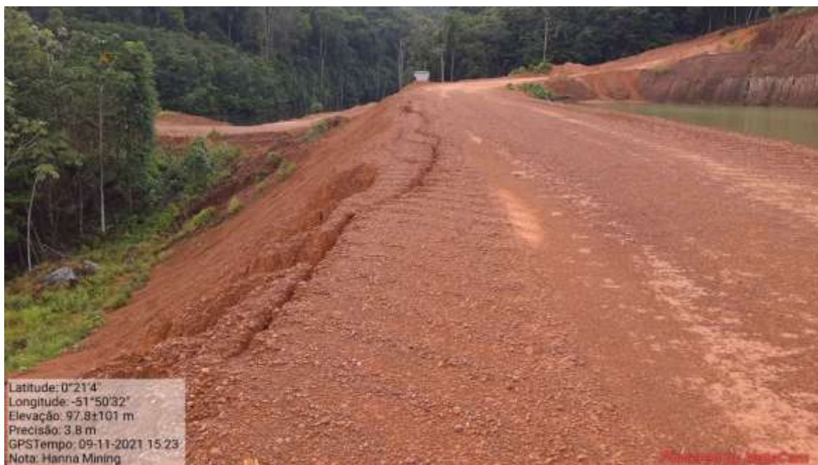
Fotografia 16 - Barragem Samacá depois da manutenção.
