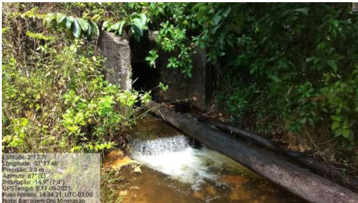
Fotografia 73 - Presença de tronco no vertedouro.
