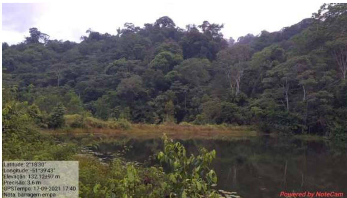
Fotografia 90 - Vegetação na barragem.
