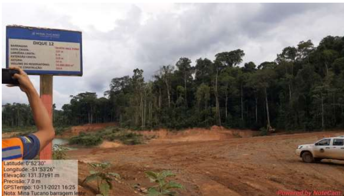
Fotografia 35 - Vista do Dique 12.
