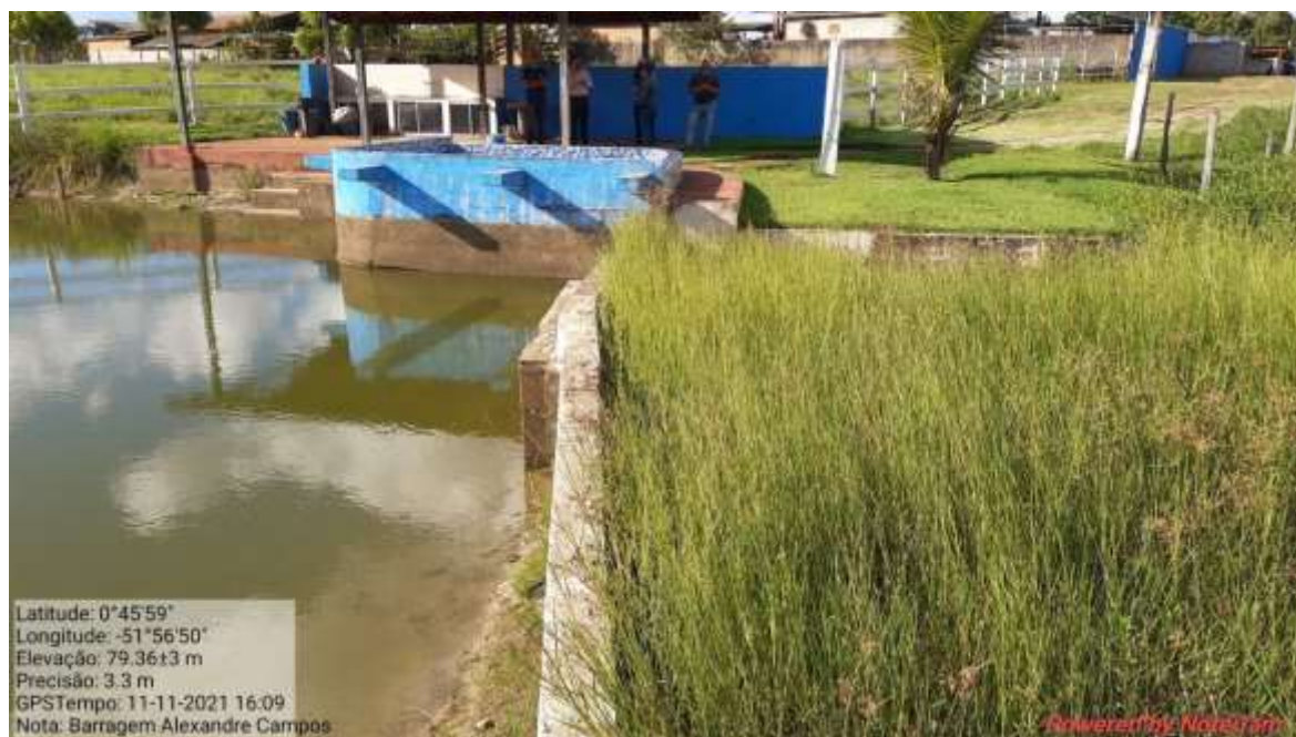
Fotografia 117 - Talude de montante de concreto.
