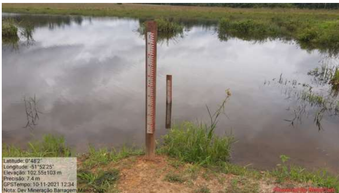
Fotografia 25 - Instalação de novas réguas na barragem Mário Cruz 1.
