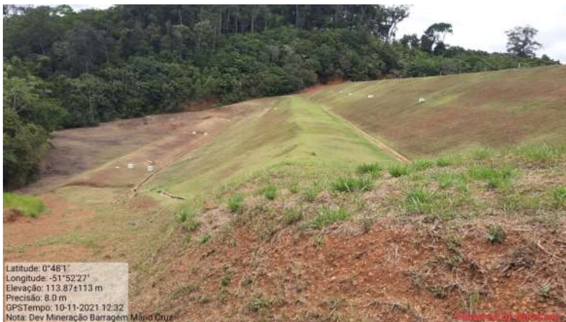
Fotografia 21 - Barragem Mário Cruz 1 após limpeza de talude e ombreiras.
