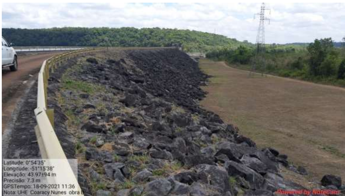
Fotografia 53 - Talude de jusante.
