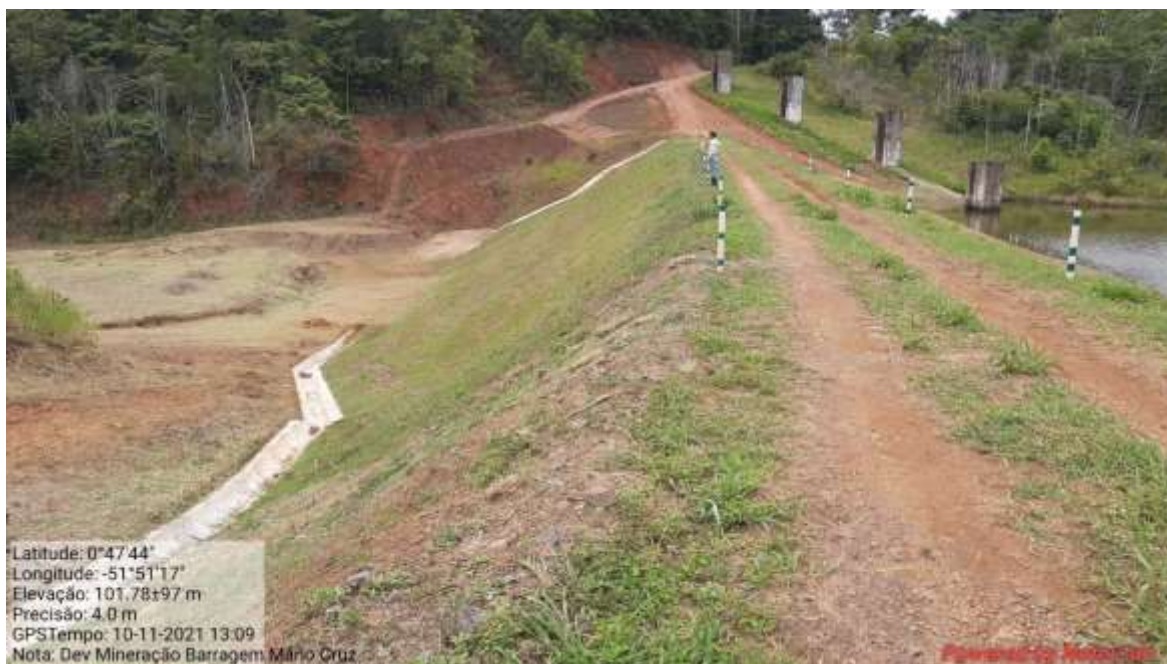
Fotografia 28 - Dique 2 sendo recuperado.
