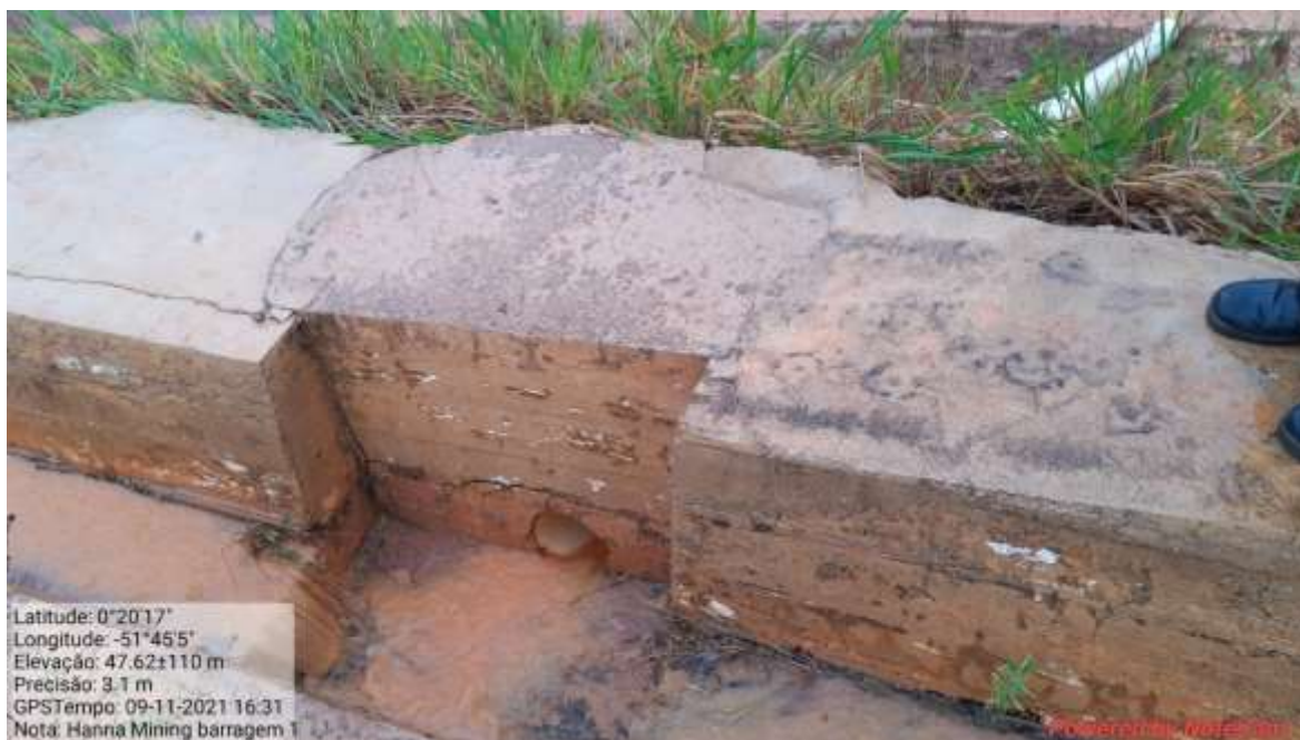
Fotografia 20 - Tubos instalados na canaleta.
