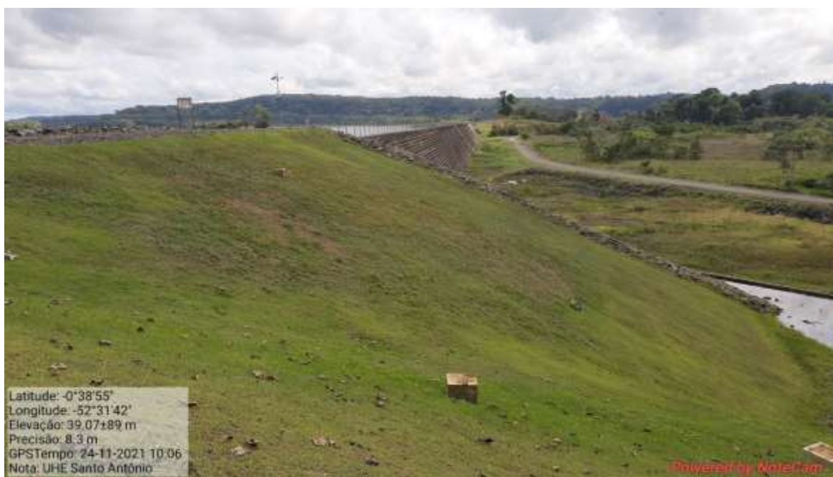
Fotografia 58 - Talude de jusante.
