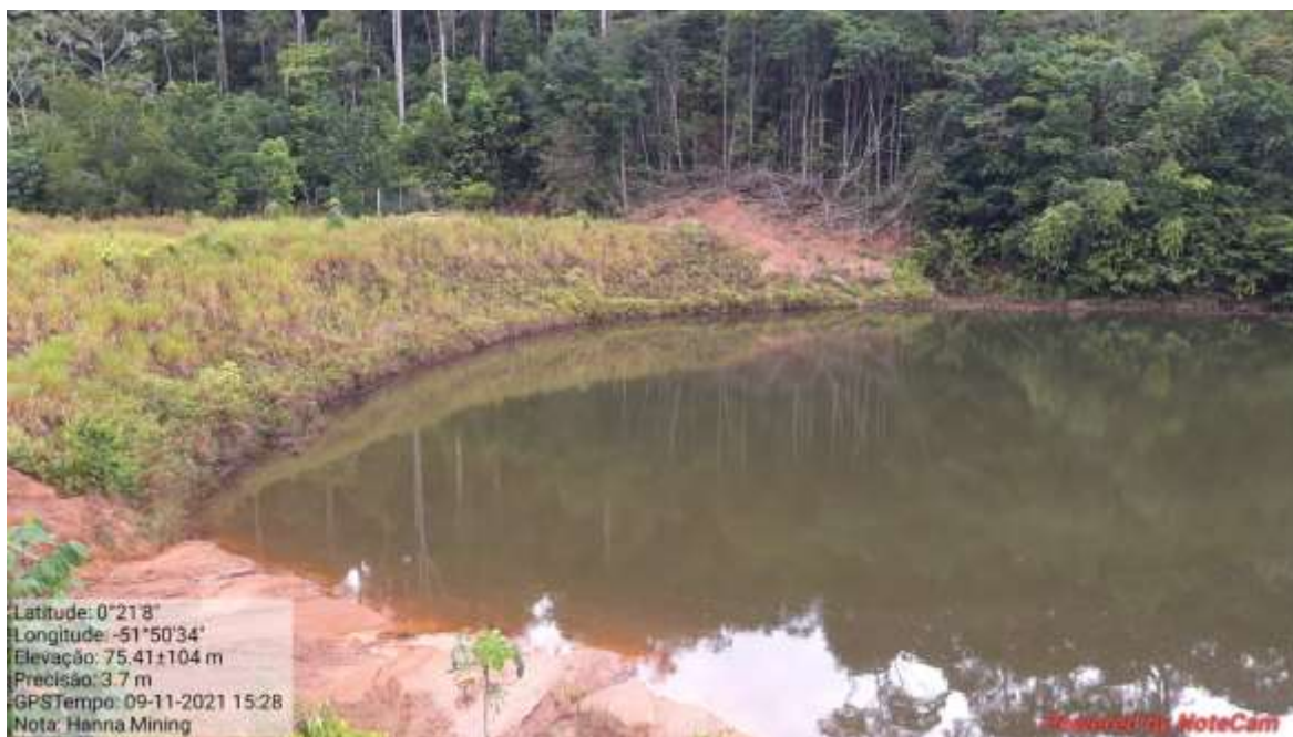
Fotografia 104 - Anomalias no talude de montante.
