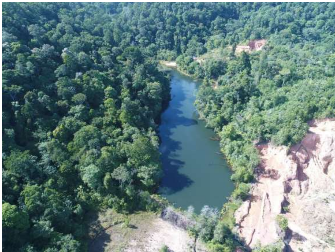
Fotografia 87 - Barragem de acumulação de água da empresa EMPA. Fonte: Fotografia de Drone (2019).
