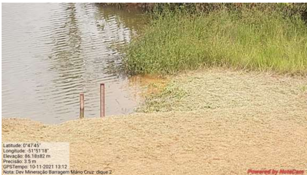
Fotografia 29 - Instalação de réguas no Dique 2.
