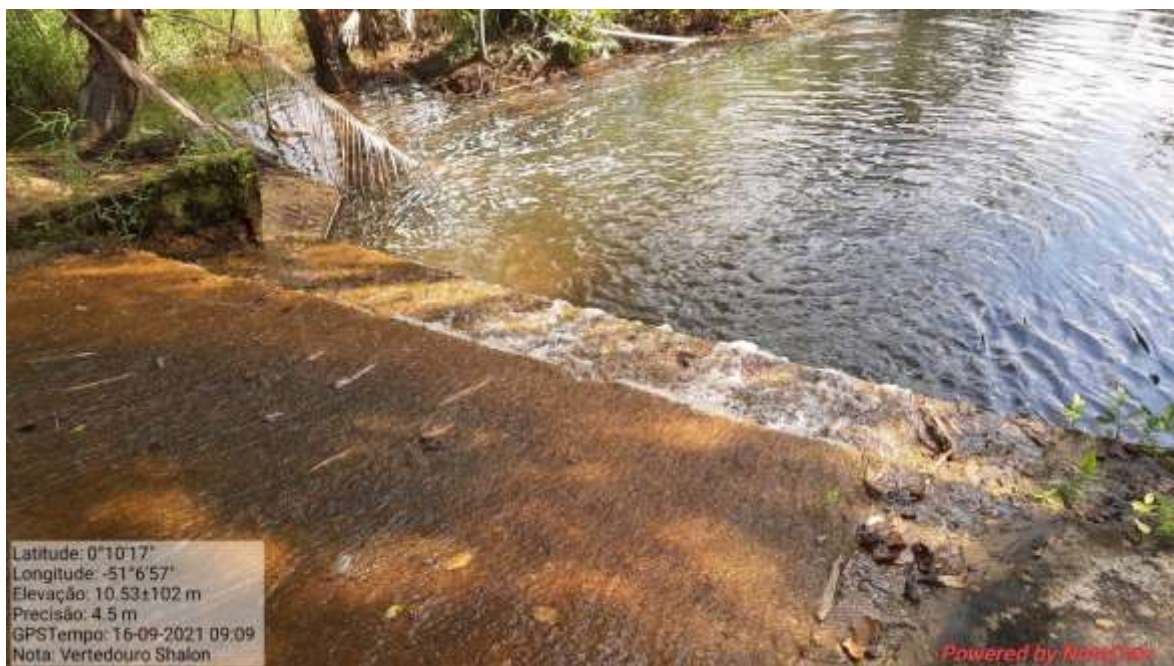
Fotografia 64 - Vertedouro de concreto.
