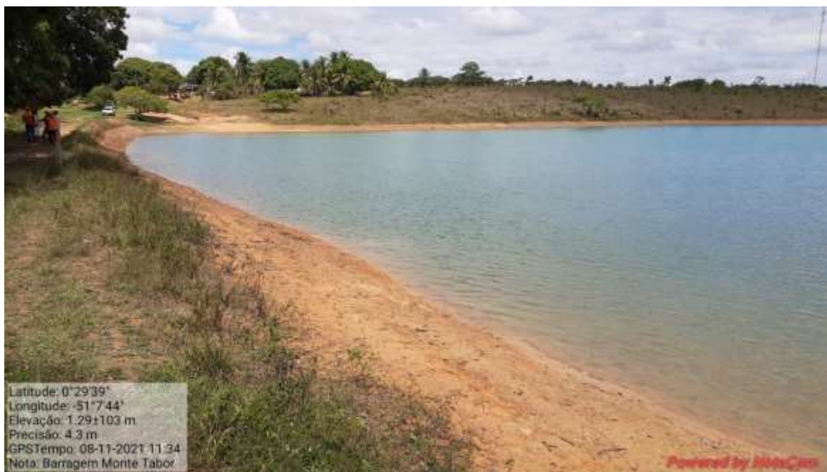
Fotografia 95 - Talude de montante.
