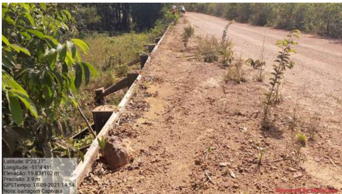
Fotografia 81 - Uso de madeira para conter erosões.
