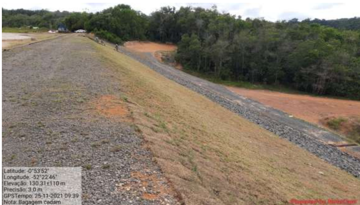
Fotografia 48 - Talude de montante protegido com gramínea.
