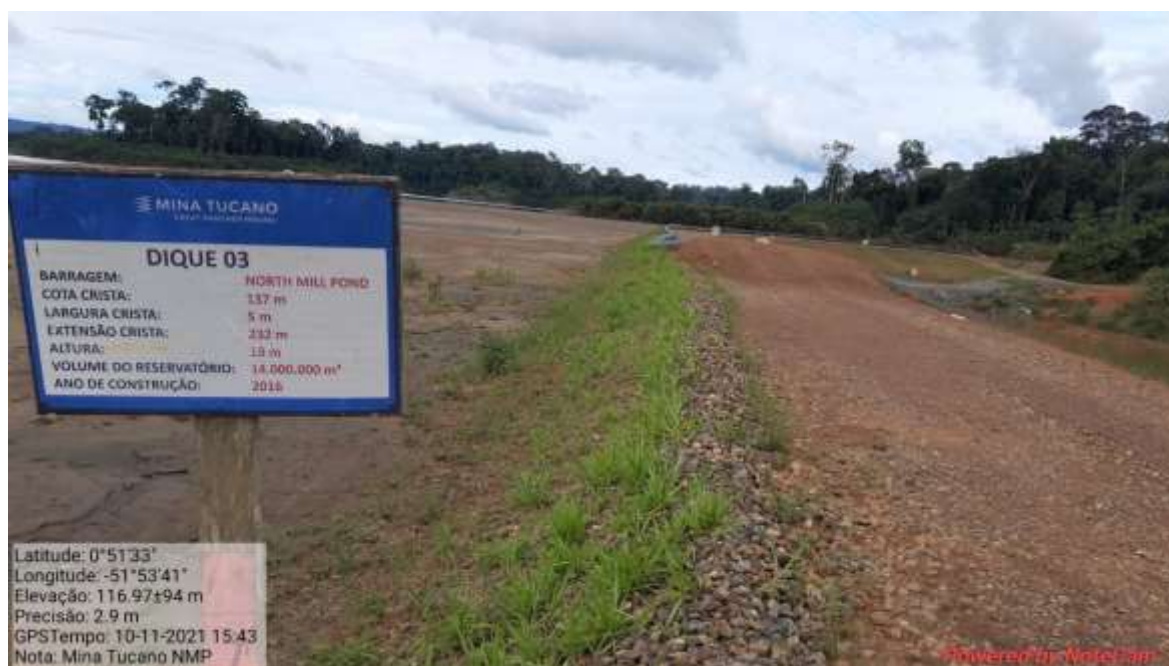
Fotografia 33 - Vista do Dique 03.
