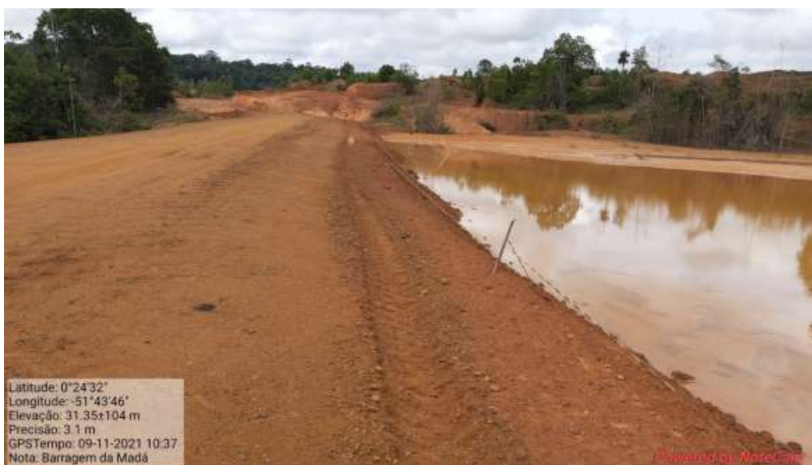
Fotografia 11 - Vista da barragem da Madá após a manutenção.
