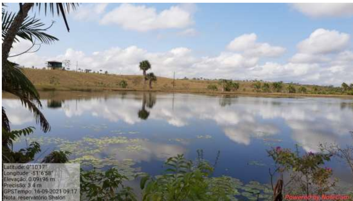
Fotografia 62 - Reservatório da barragem.
