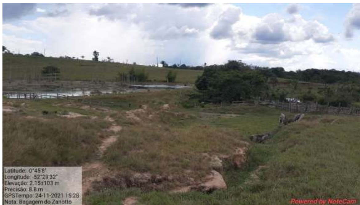
Fotografia 125 - Barragem próxima a um matadouro de boi.
