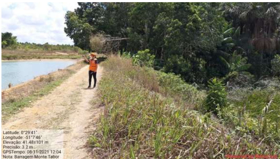
Fotografia 96 - Talude de jusante.
