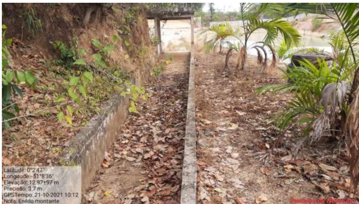
Fotografia 133 - Estrutura extravasoura de concreto.
