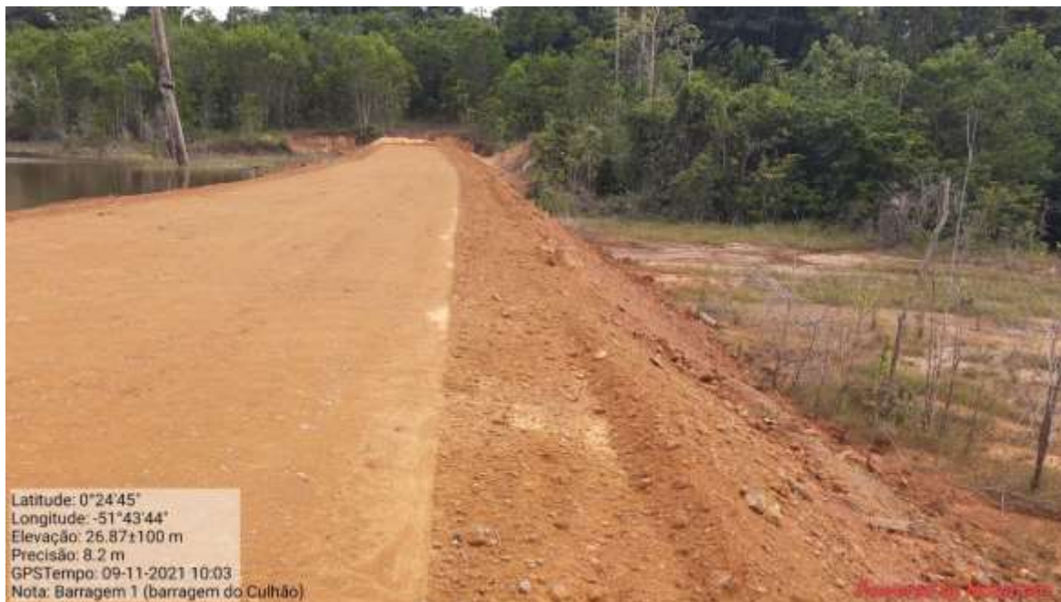
Fotografia 9 - Vista da barragem do Culhão depois da manutenção.
