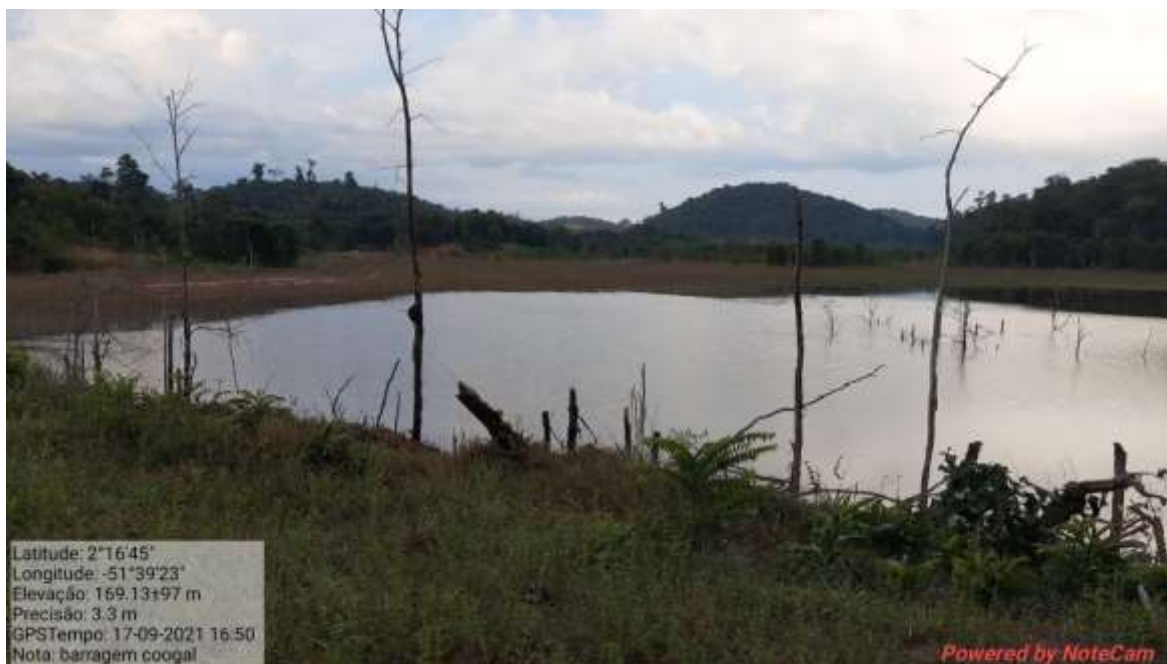
Fotografia 8 - Vista do reservatório da barragem Labourie, ao fundo, o canal extravasor construído em 2018.
