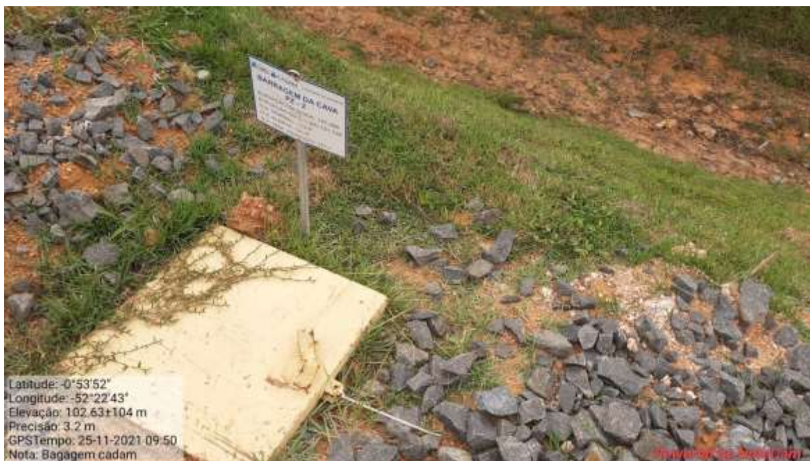
Fotografia 50 - Piezômetro.
