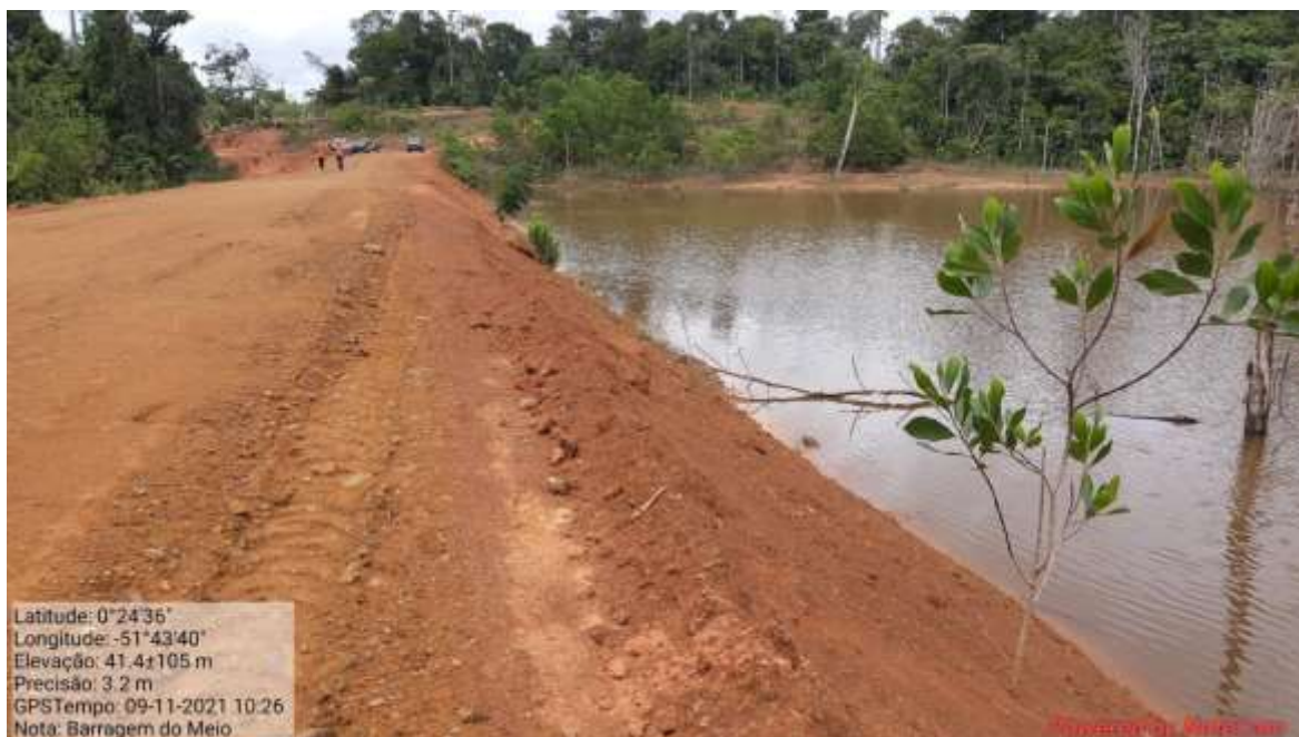
Fotografia 10 - Vista da barragem do Meio após a manutenção.
