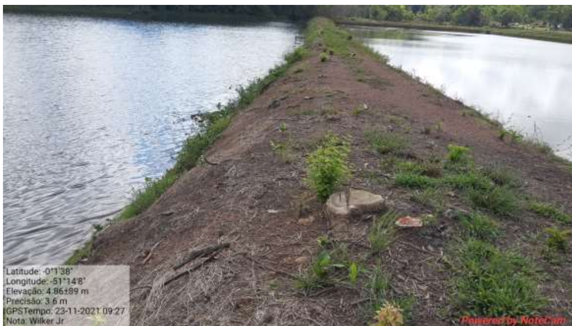
Fotografia 124 - Troncos de árvores e arbustos existentes na barragem.
