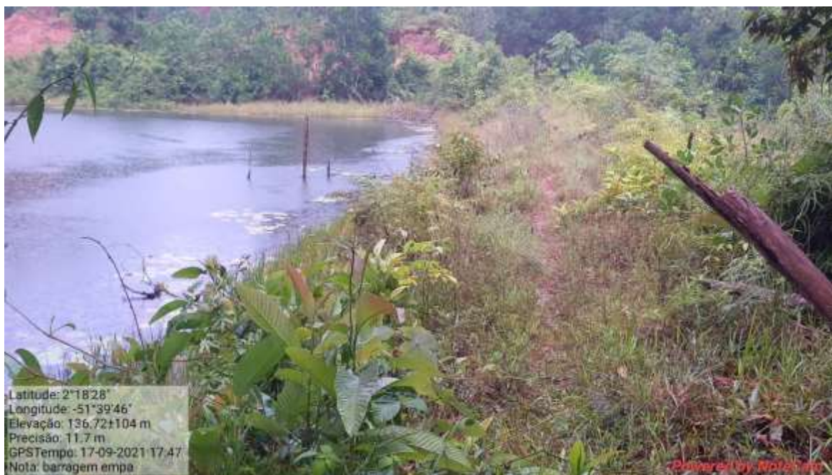
Fotografia 88 – Remoção da árvore da crista.
