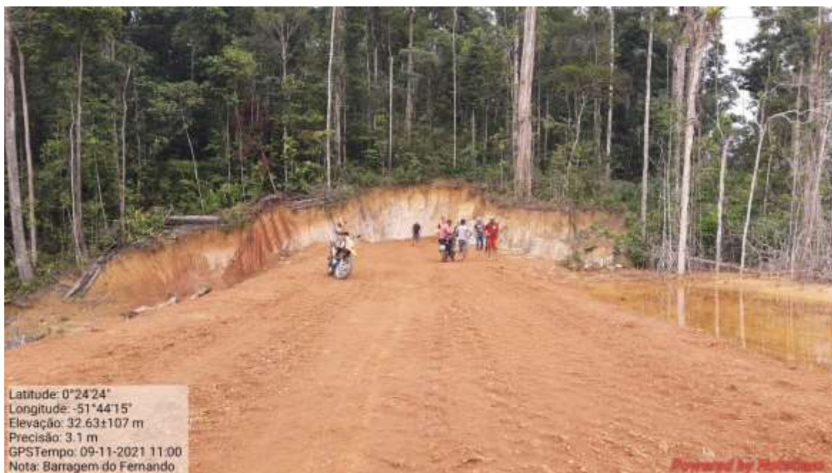
Fotografia 12 - Vista da barragem do Fernando após a manutenção.
