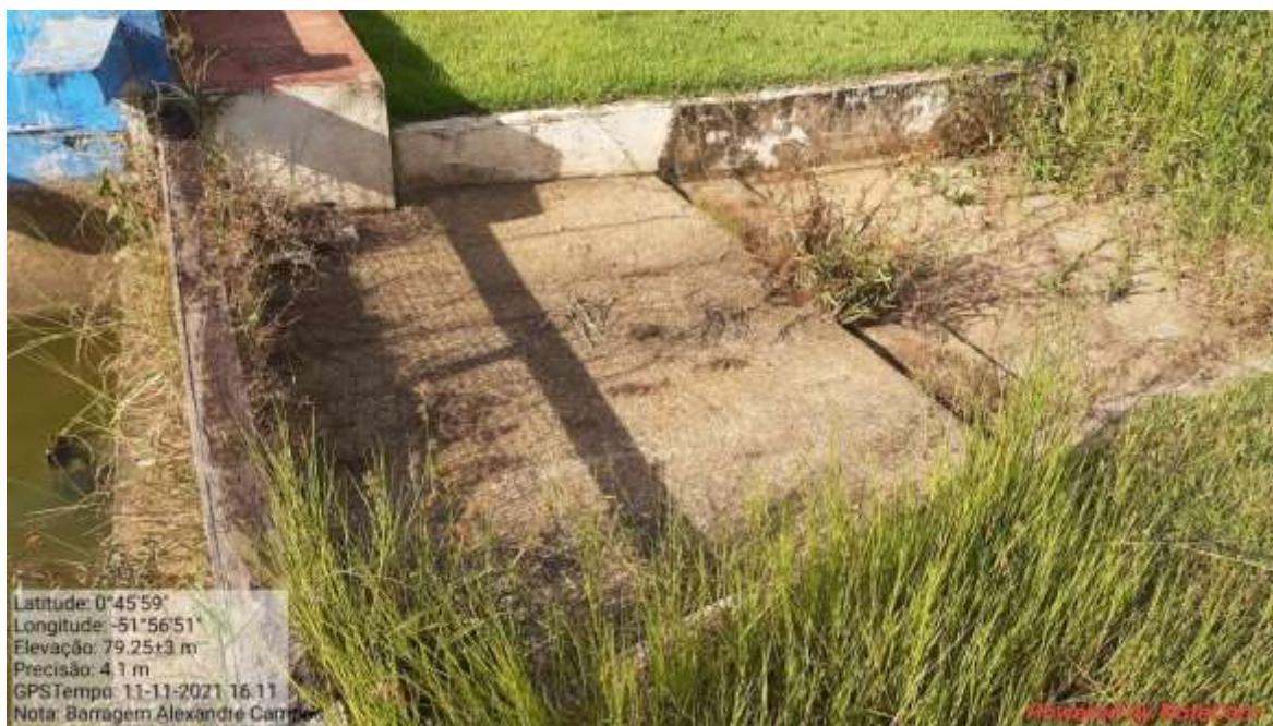
Fotografia 118 - Extravasor de concreto.
