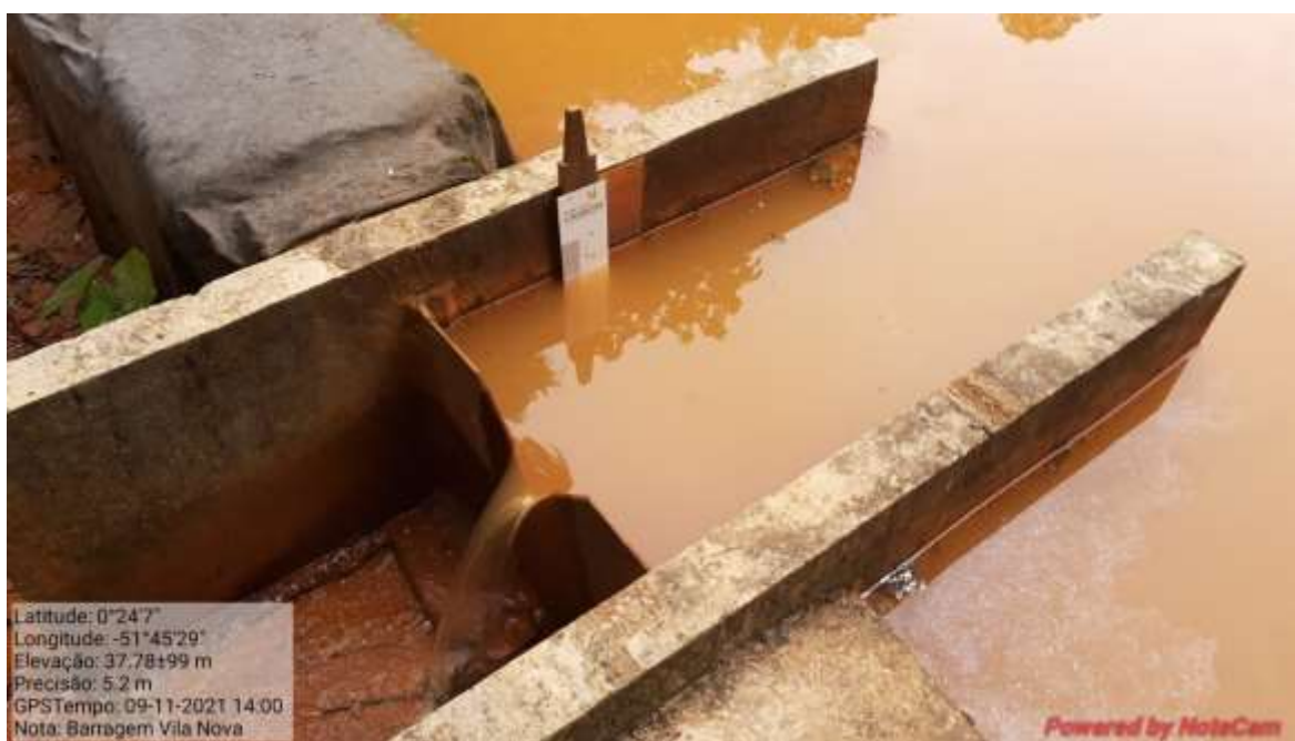
Fotografia 14 - Calha parshall para medir vazão.
