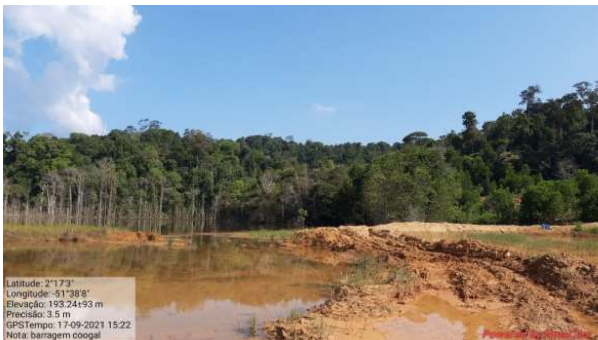
Fotografia 3 - Barramento em corpo hídrico no limite entre Oro e Coogal.
