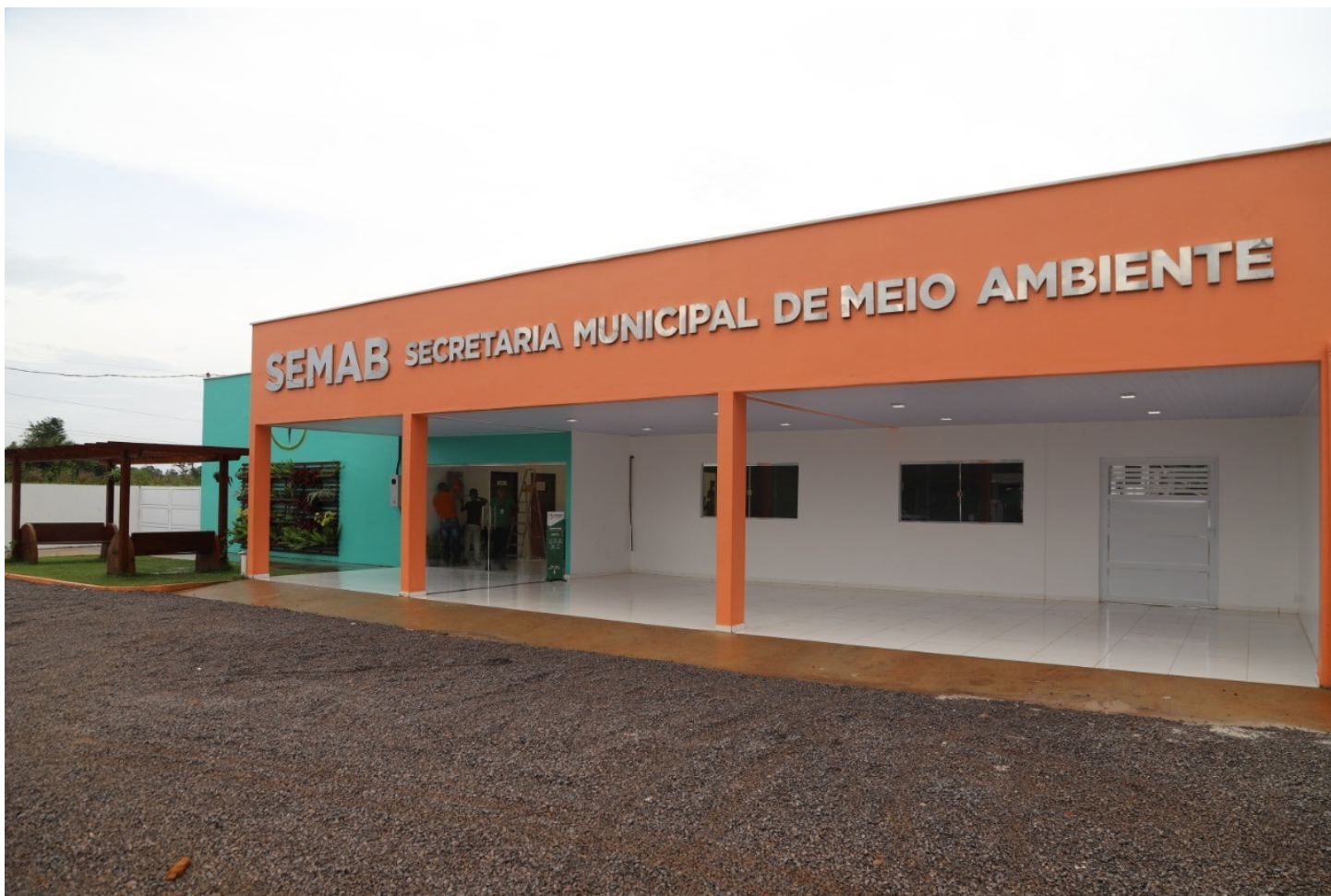
Fachada da sede da secretaria de meio ambiente de Pedra Branca do Amapari
