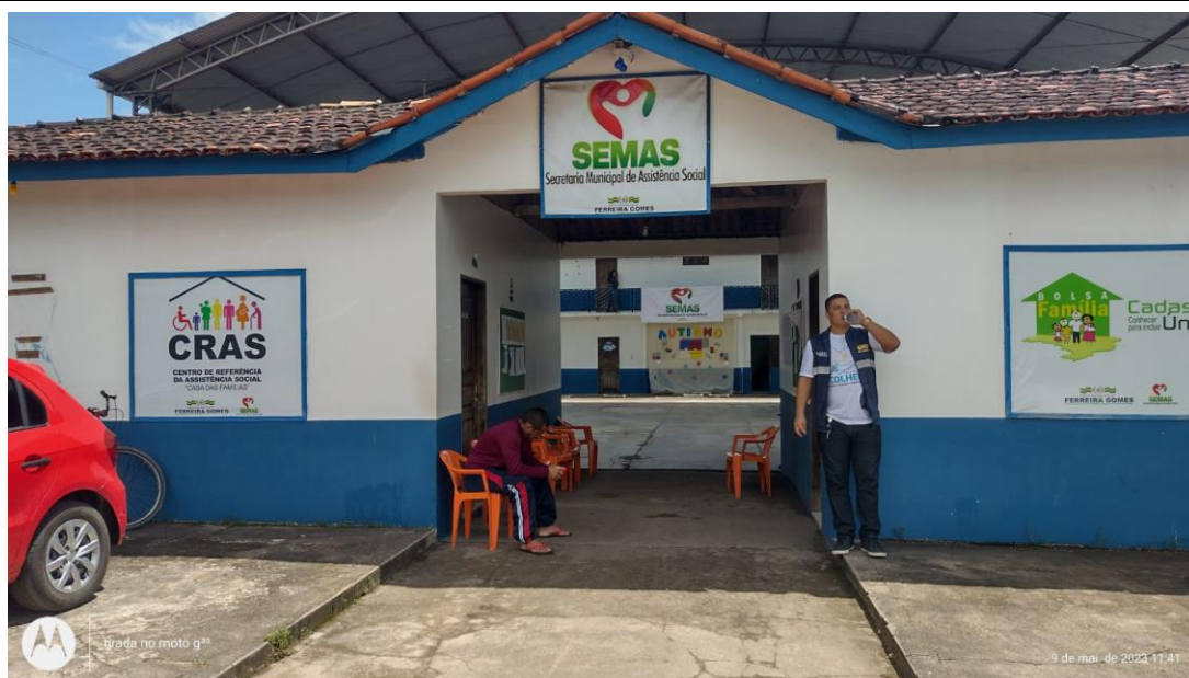
Foto 01: Faixada do Prédio do CRAS
