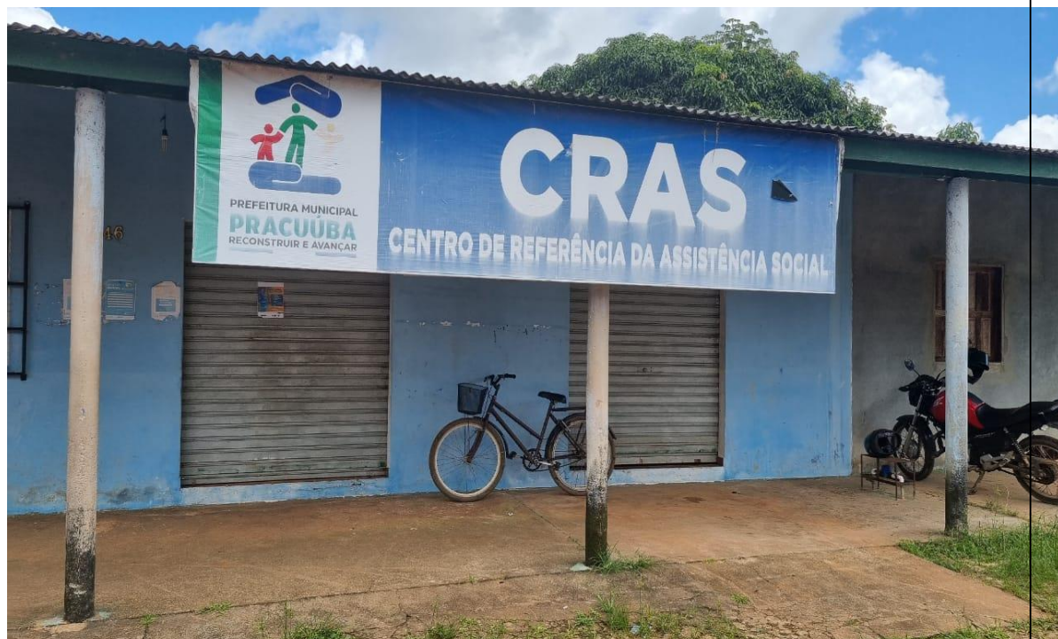
Foto 01: Faixada do Prédio do CRAS
