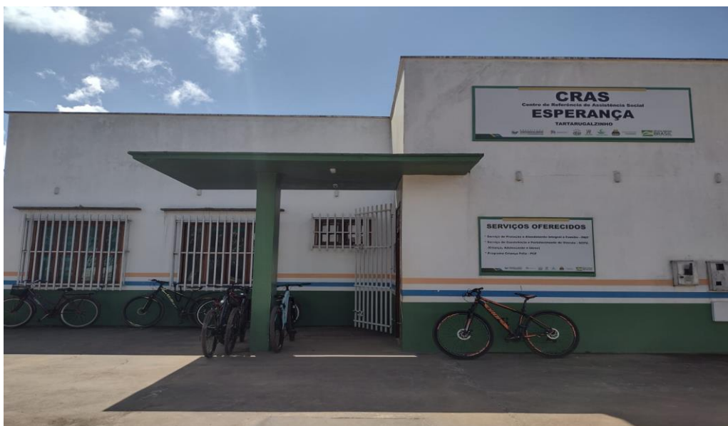
Foto 03: Faixada do Prédio do CRAS
