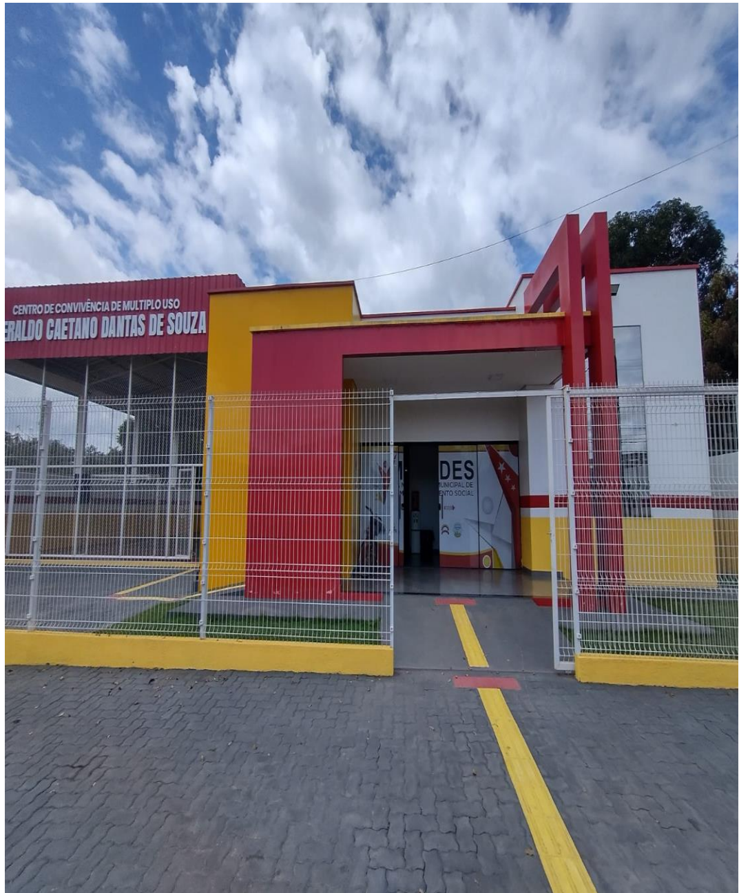
Foto 01: Faixada do Prédio do CRAS
