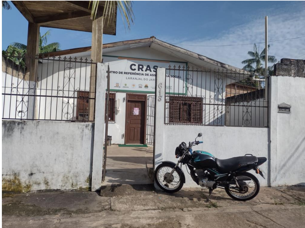
Foto 03: Faixada do Prédio do CRAS
