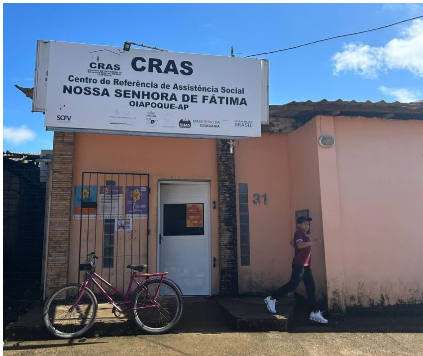
Foto 01: Faixada do Prédio do CRAS
