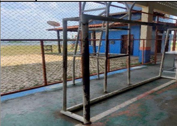
CALÇAMENTO EM BLOCOS DE CONCRETO COM PINTURA DESGASTADA
