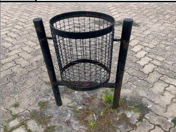
LIXEIRA DESGASTADA E SEM O FUNDO
